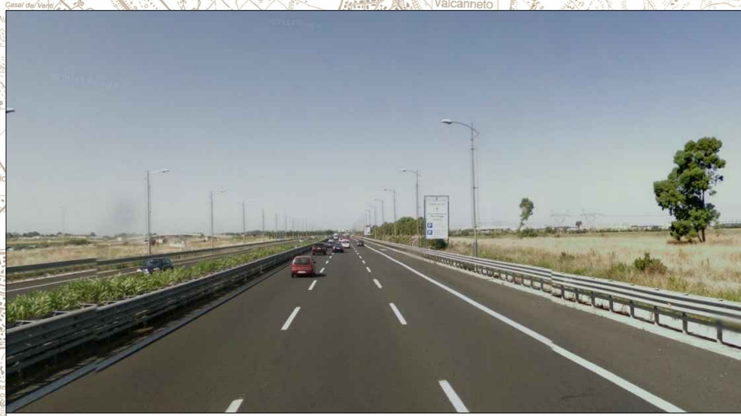
Autostrada Roma - Fiumicino
