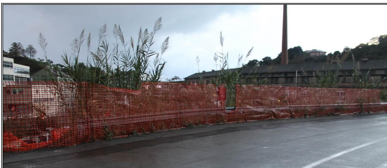
Figura 1 - Area industriale dismessa
