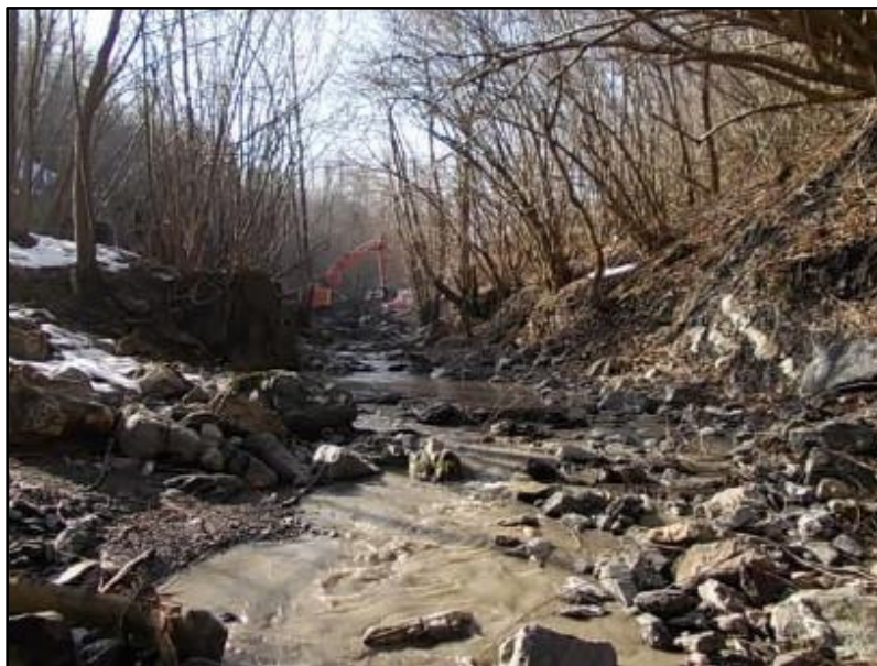
Foto 6.1: Foto della stazione T-FR-010 verso monte (notare i mezzi di cantiere per il movimento terra).
