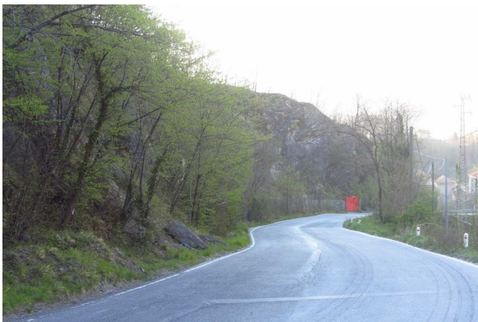
Fig. 1. FAU-CM-040. Panoramica della stazione di monitoraggio.
