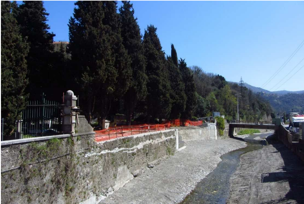
Foto 1. FAU-GE-060. Veduta dell'area di monitoraggio
