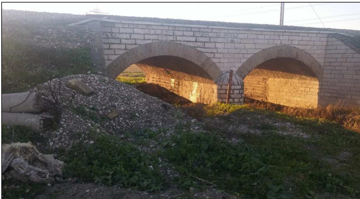
*Figura 6.9: Rilevato ferroviario con ponte in muratura lungo il confine di monte dell'area in esame in destra idrografica.*
