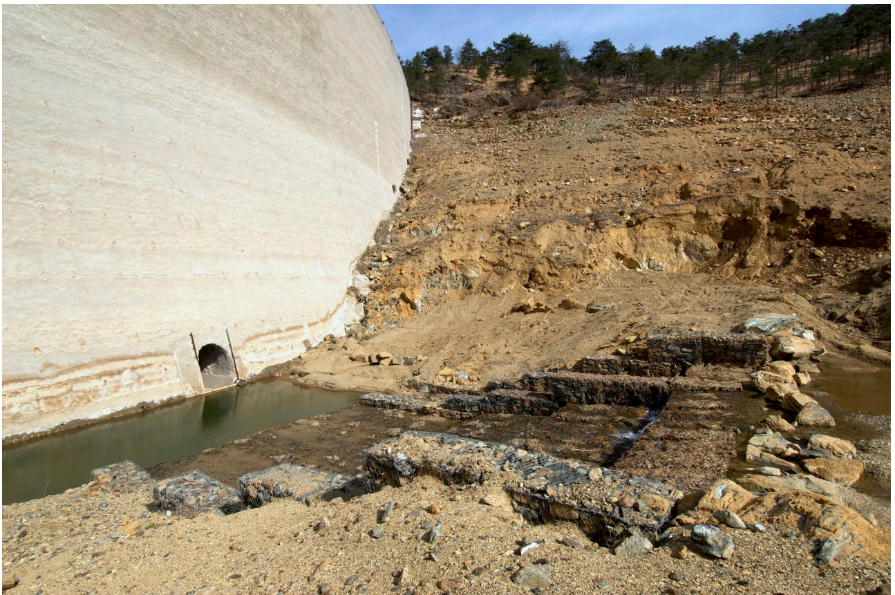
Figura 3. Dettaglio della gabbionata realizzata a monte del corpo diga.
