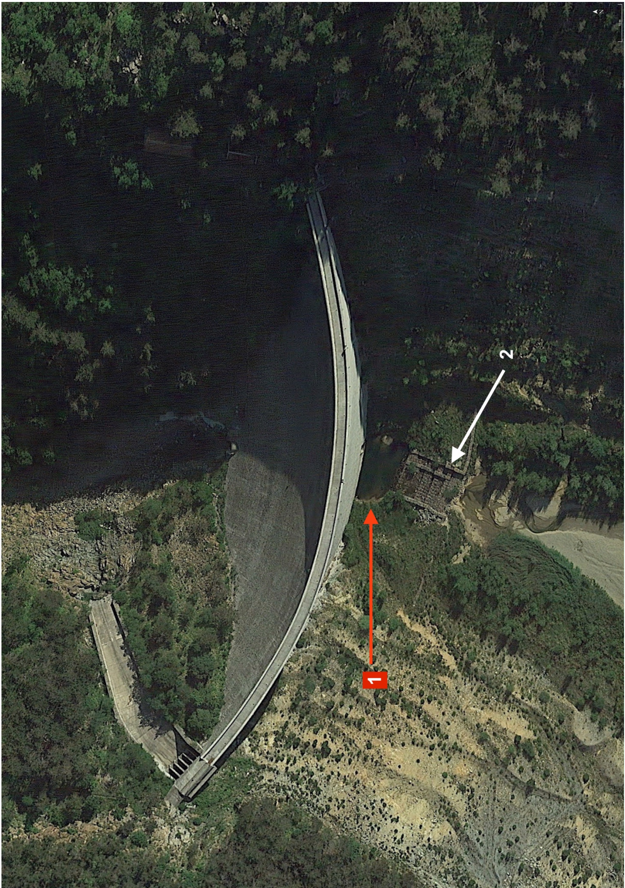
Figura 4. Vista area della diga: in 1 la piccola area bagnata compresa tra la gabbionata (2) e il corpo diga (immagine Google Earth ripresa il 30/08/2015).
