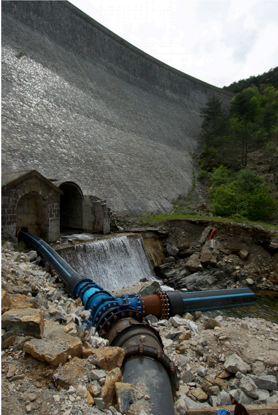
Figura 1. Vista a valle del corpo diga: in primo piano la tubazione realizzata per allontanare le acque dello scarico di fondo e, in secondo piano, l'uscita del cunicolo di ispezione con le acque di scorrimento.
