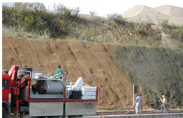
Figura 5-5 Esempio di spargimento miscela per via idraulica
