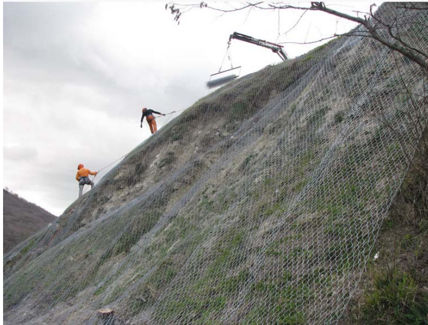
Figura 5-13 Fase di stesura rete metallica su parete
