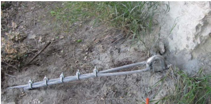
Figura 5-20 Esempio fissaggio fune perimetrale
