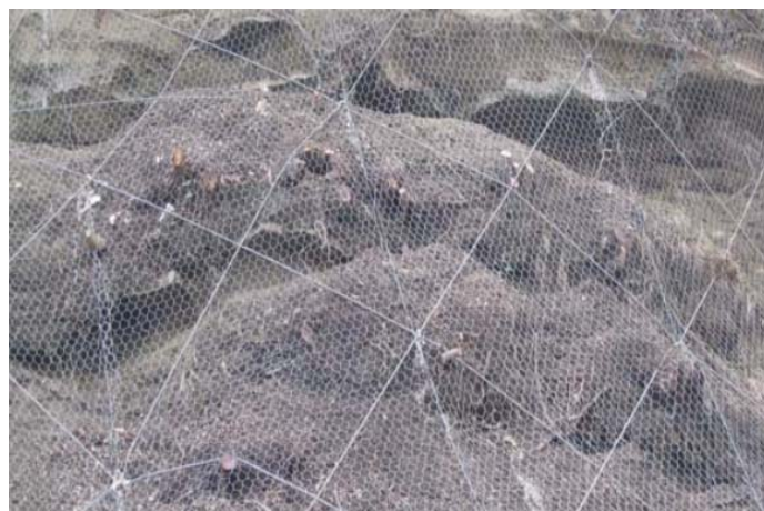
Figura 5-17 Esempio funi di rinforzamento corticale
