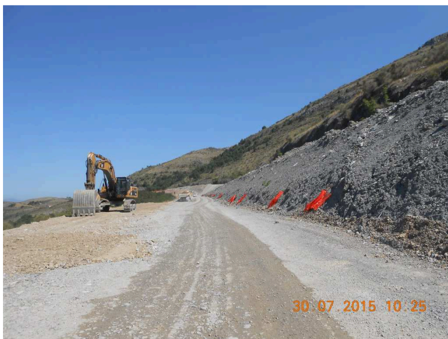
Figura 10: Ritombamento costone tra Viadotto Pianicelli 2 e Viadotto Caffaro – area critica 5
