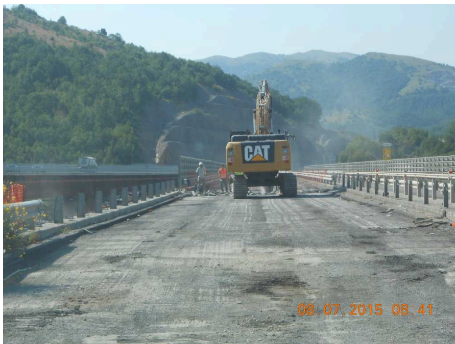
Figura 11: Demolizione meccanica prima campata – Viadotto Caffaro carr. Nord
