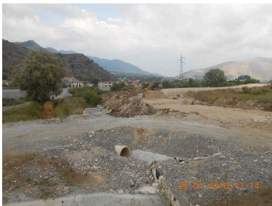
Figura 12: Dismissione rilevato vecchio svincolo Lauria Sud
