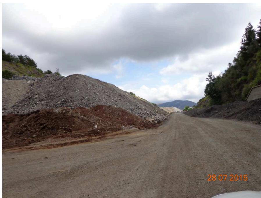
Figura 4: Ritombamento costone imbocco sud galleria Serra Rotonda – area critica 2
