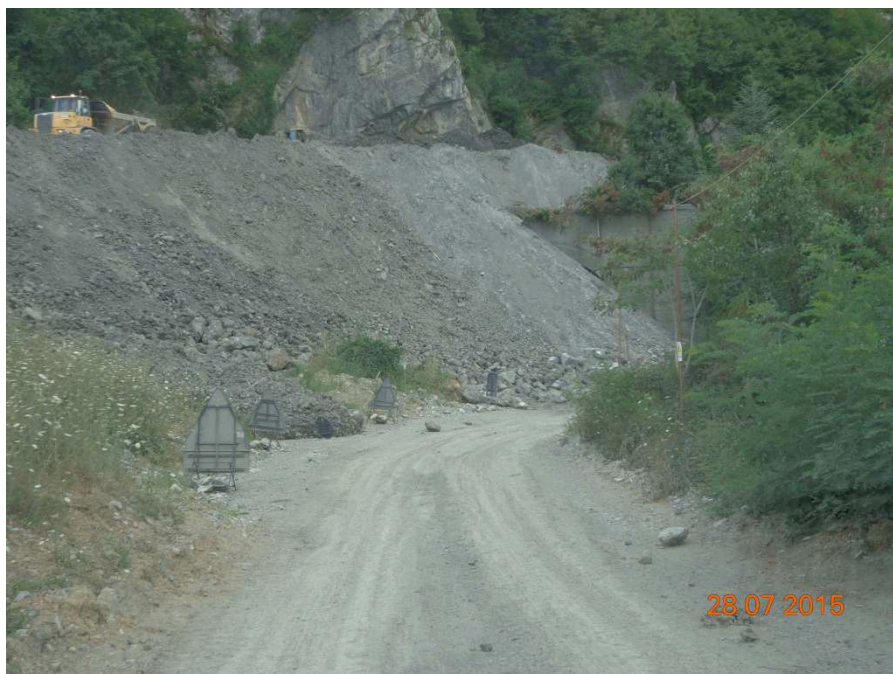
Figura 2: Ritombamento vecchia galleria Serra Rotonda imbocco nord carr. nord – area critica 1
