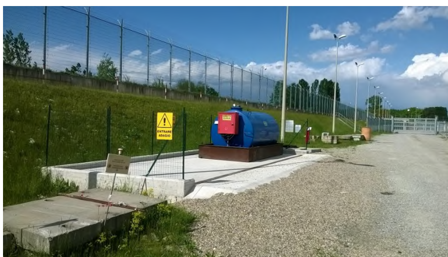
Figura 2-2 - Piazzola di stoccaggio dei materiali/rifiuti pericolosi
