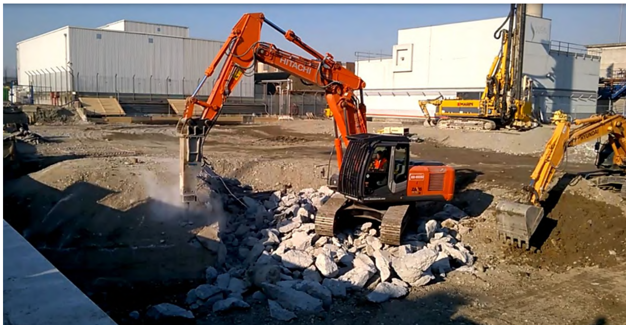
Figura 2-1 – Demolizione del basamento di fondazione della torre idrica
