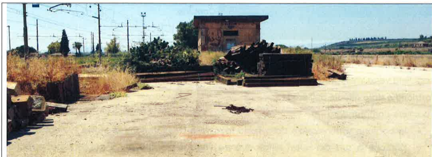
Vista dell'area destinata al cantiere di armamento, in corrispondenza dell'ex scalo ferroviario di Motta S. Anastasia.
