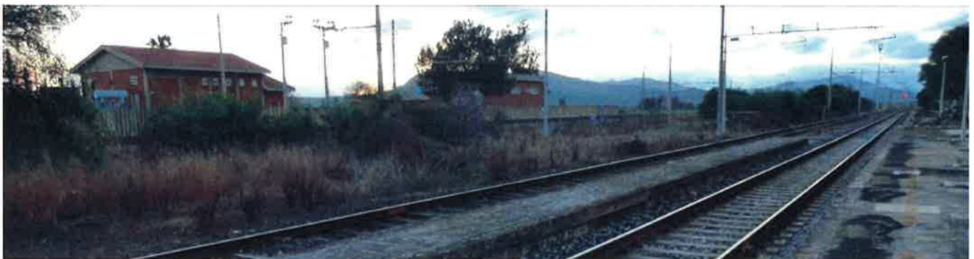
Vista dalla stazione di Sferro dei binari di linea e dei binari di scalo in stato di abbandono.
