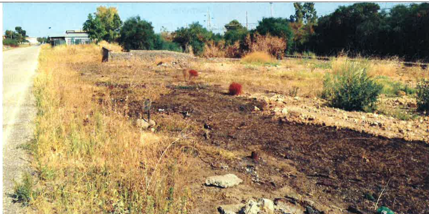
Vista dell'area destinata al cantiere per la realizzazione del cavalcaviaferrovia a Sferro.
