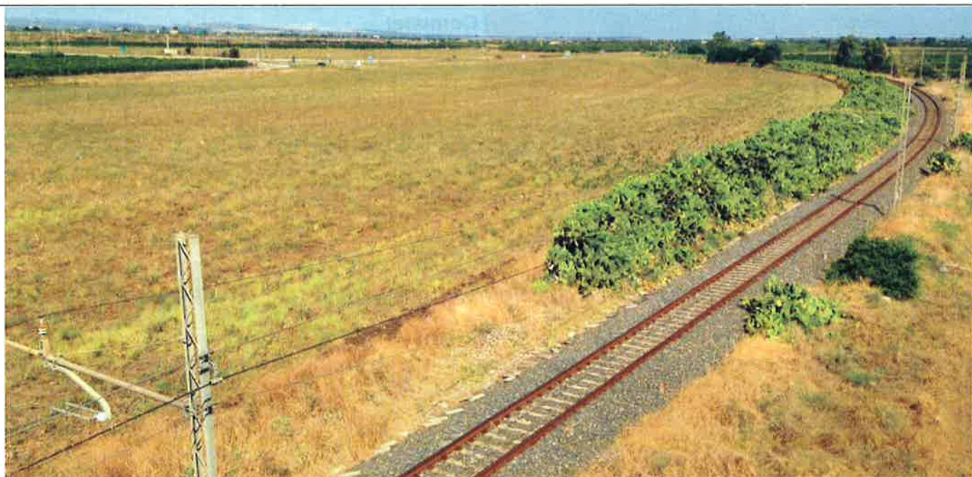
Vista dell'area destinata al cantiere base dal cavalcaferrovia esistente.
