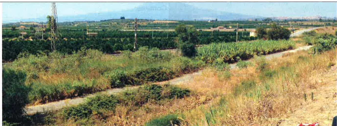
Vista dell'area destinata al cantiere per la realizzazione del viadotto sul fiume Simeto.
