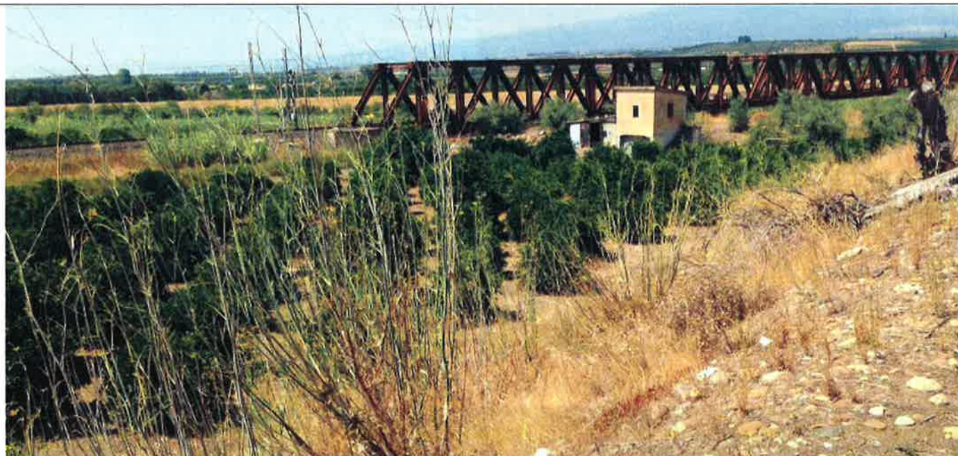
Vista dell'area destinata al cantiere per la realizzazione dello scavalco del fiume Simeto.
