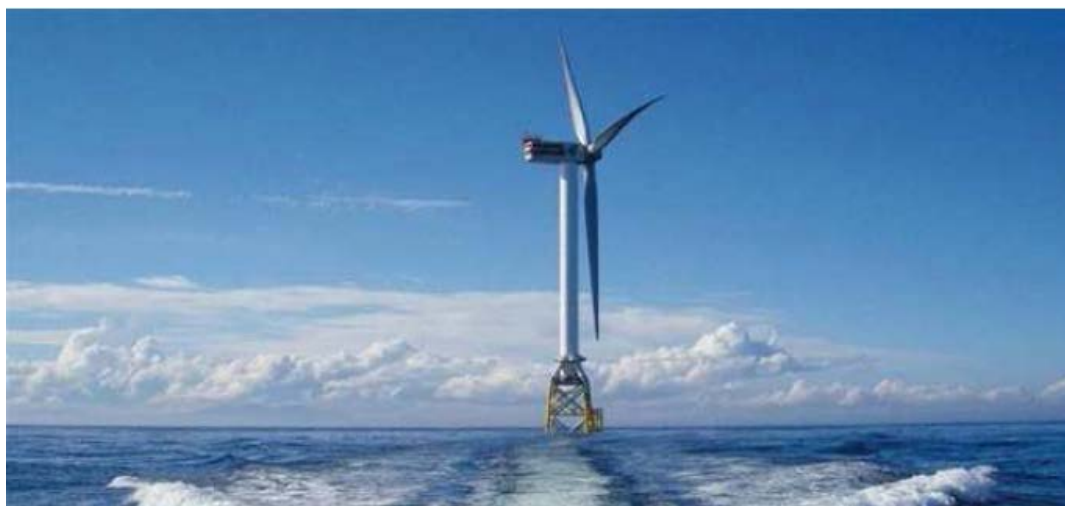
Fig. 2-10 Struttura portante a jacket per turbina eolica 5M montata a Moray Firth (REpower)
