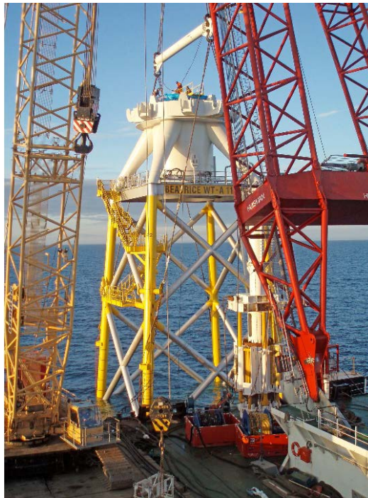
Fig. 2-15 Fondazione a castello a quattro montanti per turbina eolica 5M, mentre si sta predisponendo lo zoccolo di base della torre (REpower)
