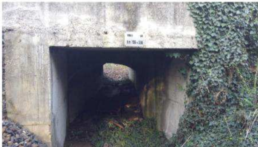
Figura 59 – Attraversamento della linea ferroviaria esistente
