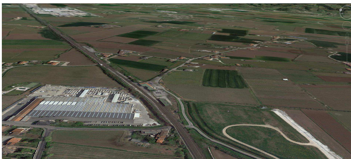
1. Stato di fatto - Area nuova stazione di Lonigo - Vista d'insieme
