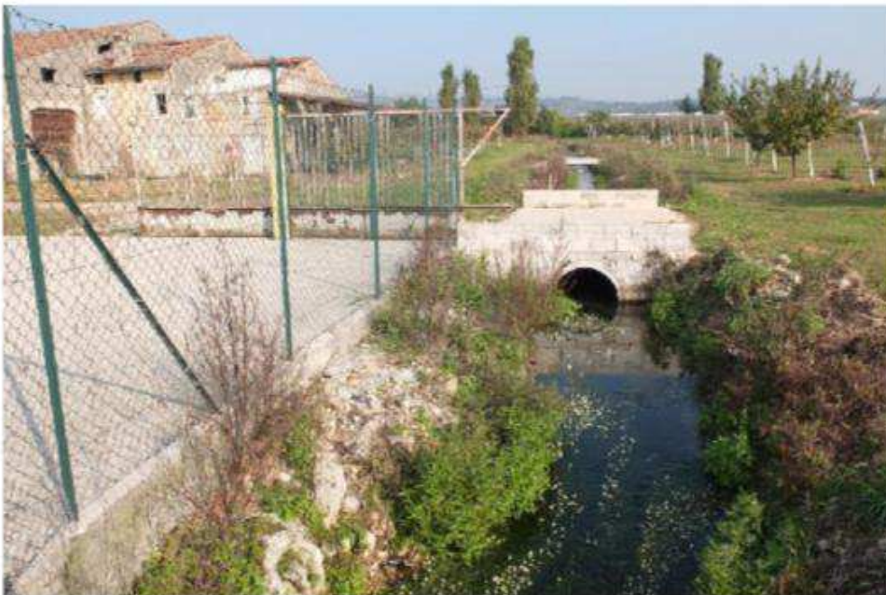
Figura 61 – Fossa Zenobria a sud della tangenziale
