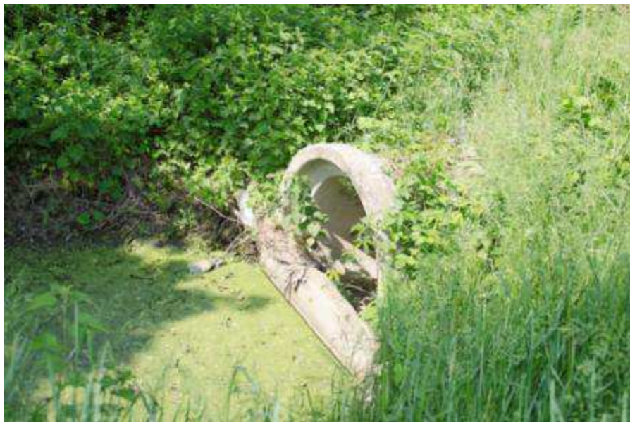
Figura 5 – Scolo ferroviario Altavilla, stato di fatto in corrispondenza della LS.
