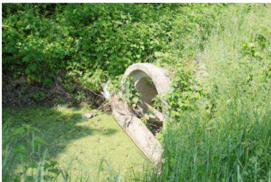
Figura 19-11 – Scolo ferroviario Altavilla, stato di fatto in corrispondenza della LS.
