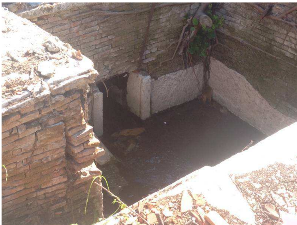
Foto 5 – “Mulino”: sezione di ingresso delle acque di risorgiva
