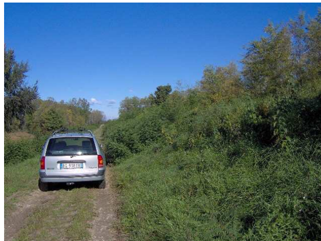
Foto 3: l'argine in destra orografica del Torrente Torre in località Tapogliano
