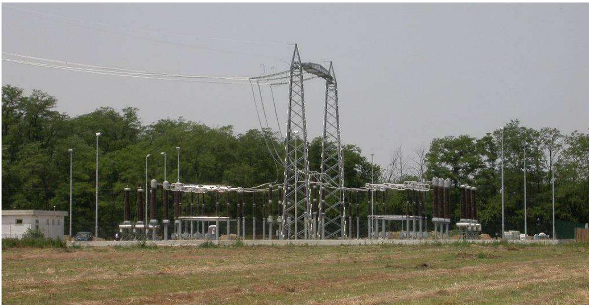
*Figura 6-7– Stazione di transizione aereo/cavo priva di reattanze per linea 380 kV in semplice terna.*
