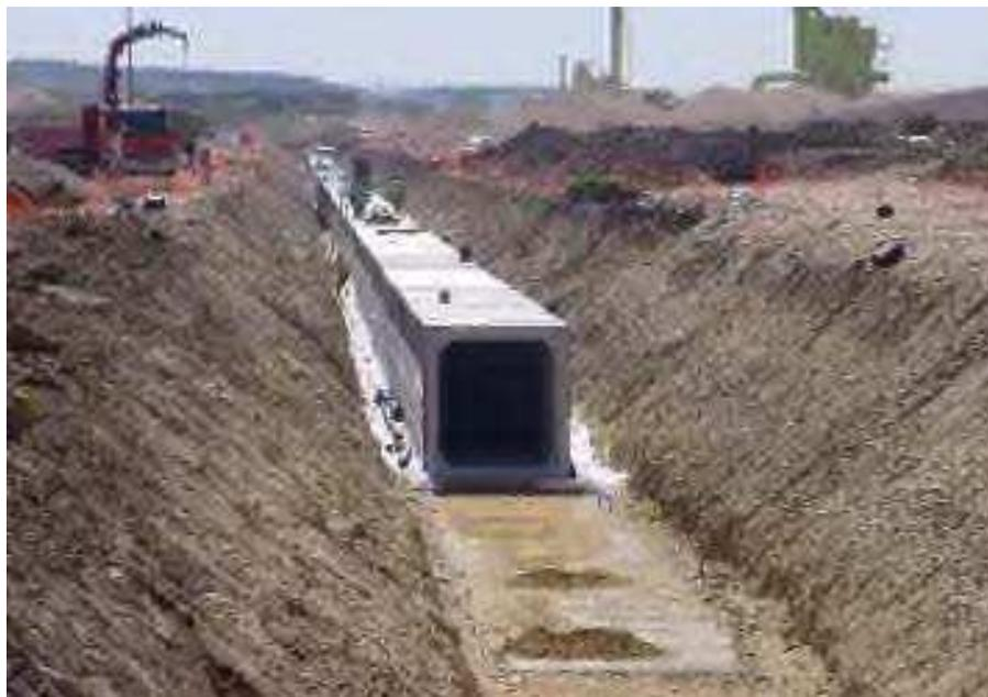
*Figura 6-3– Realizzazione di galleria in cui alloggiare cavo a 380 kV sotto aeroporto di Barajas a Madrid*
