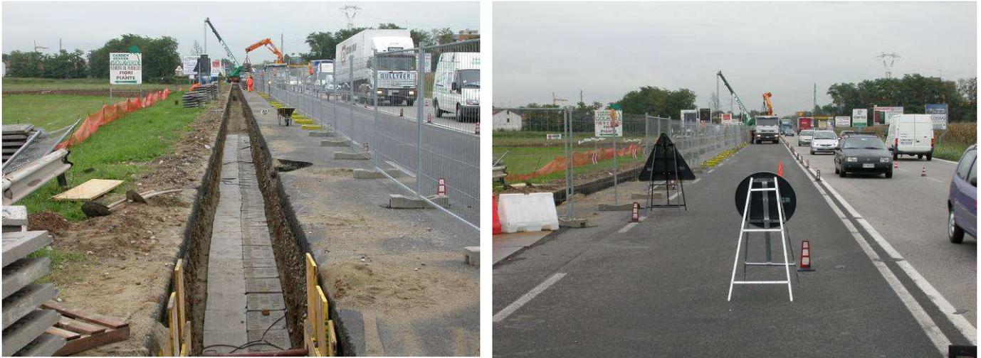
*Figura 6-8– Esempio di posa di una trina di cavi su strada statale per linea 380 kV .*
