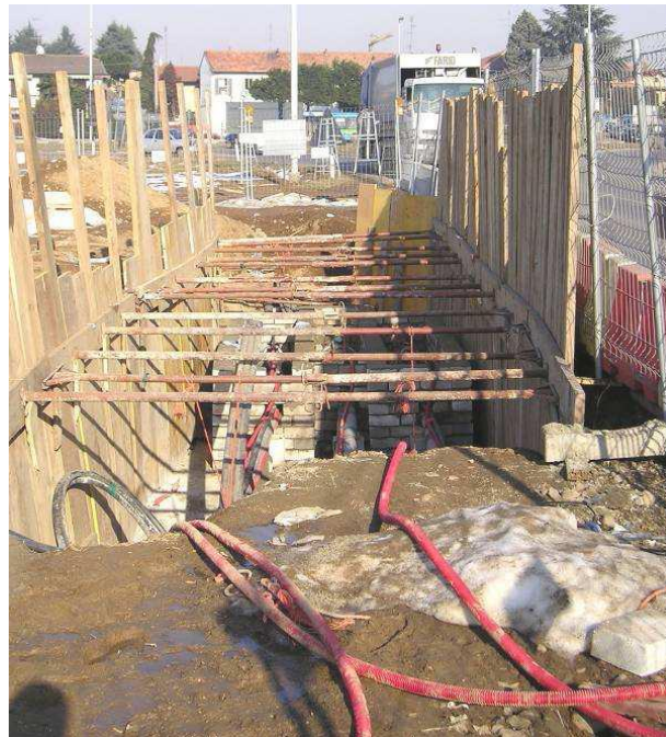
Figura 2-7 – Vista interna ed esterna di buca giunti in fase di realizzazione
