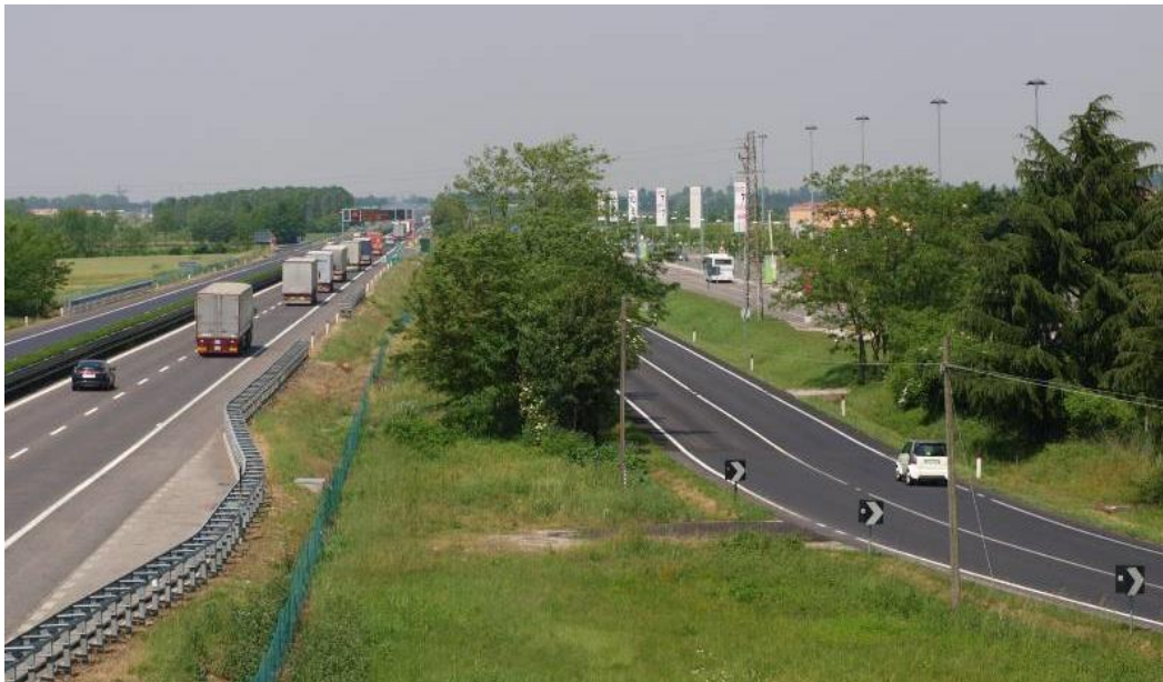
Foto 11 – Viabilità di accesso al "Palmanova Outlet Village"
