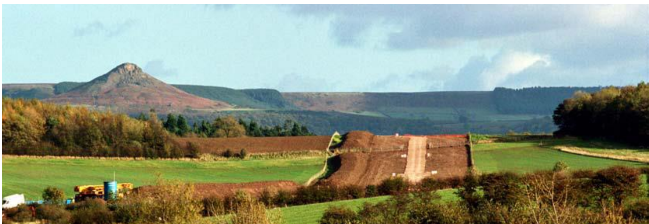
Figura 2-10- Posa di cavi interrati in campagna
