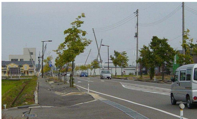
Figura 2-15– effetti derivanti da liquefazione (evento sismico a Chuetsu in Giappone)
