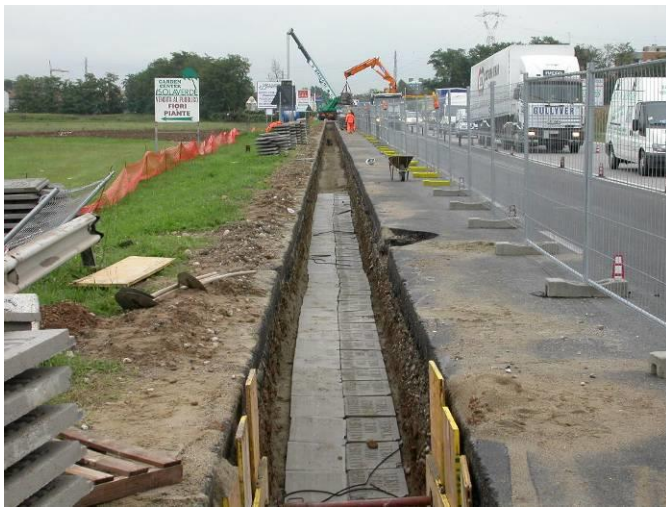
Figura 2-11 - Esempio di posa di una trincea di cavi su strada statale per linea 380 KV.
