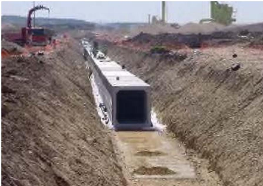
*Figura 2-3- Realizzazione di galleria in cui alloggiare cavo a 380 kV sotto aeroporto di Barajas a Madrid*
