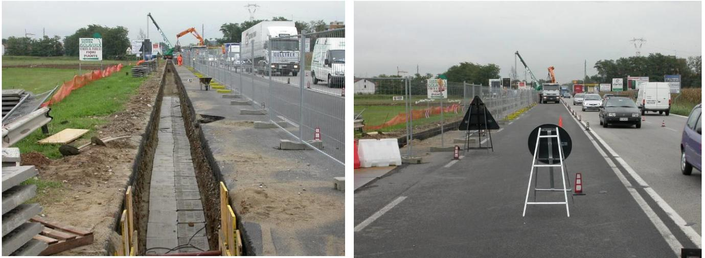
*Figura 2-8 - Esempio di posa di una terna di cavi su strada statale per linea 380 kV.*
