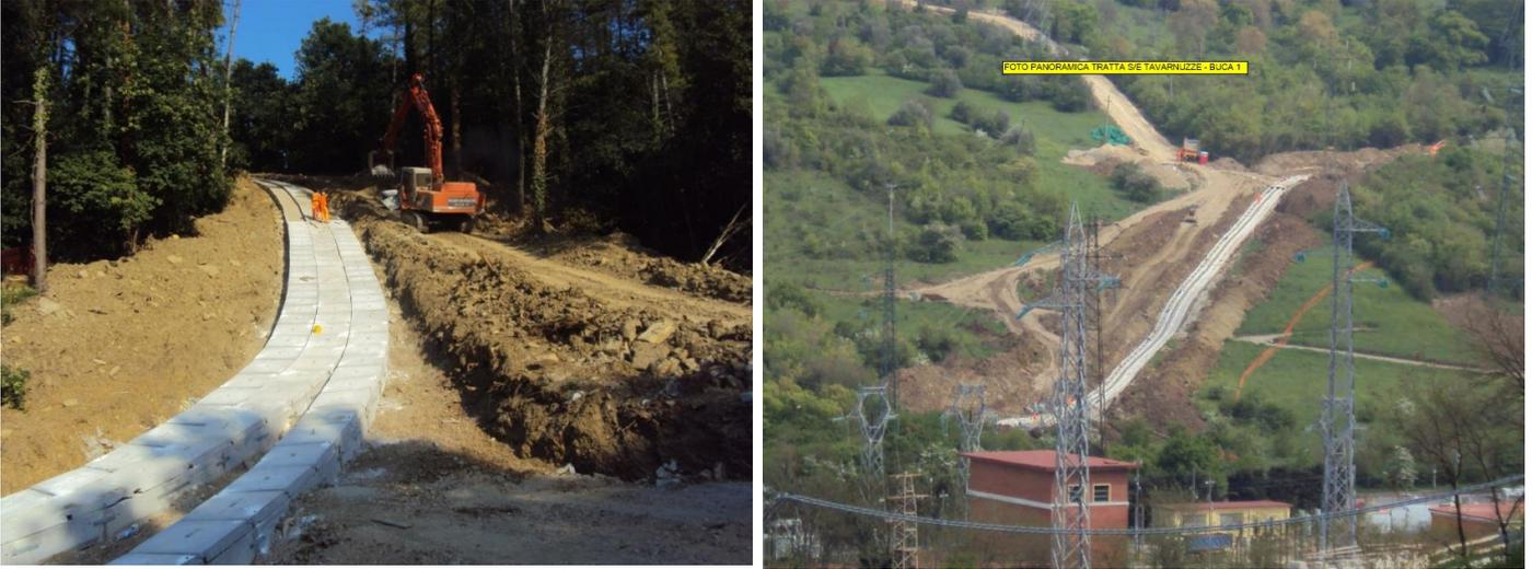
**Figura 2-7 – Tratto interrato dell'elettrodotto 380kV S. Barbara - Tavarnuzze in ambiente agricolo-boschivo**
