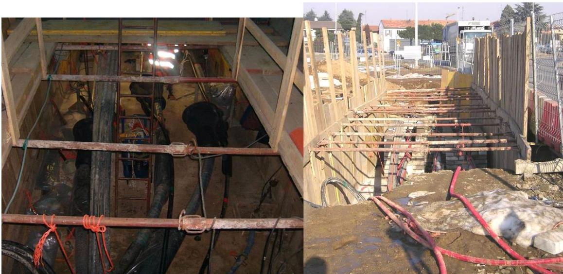
**Figura 2-8 – Vista interna ed esterna di buca giunti in fase di realizzazione**
