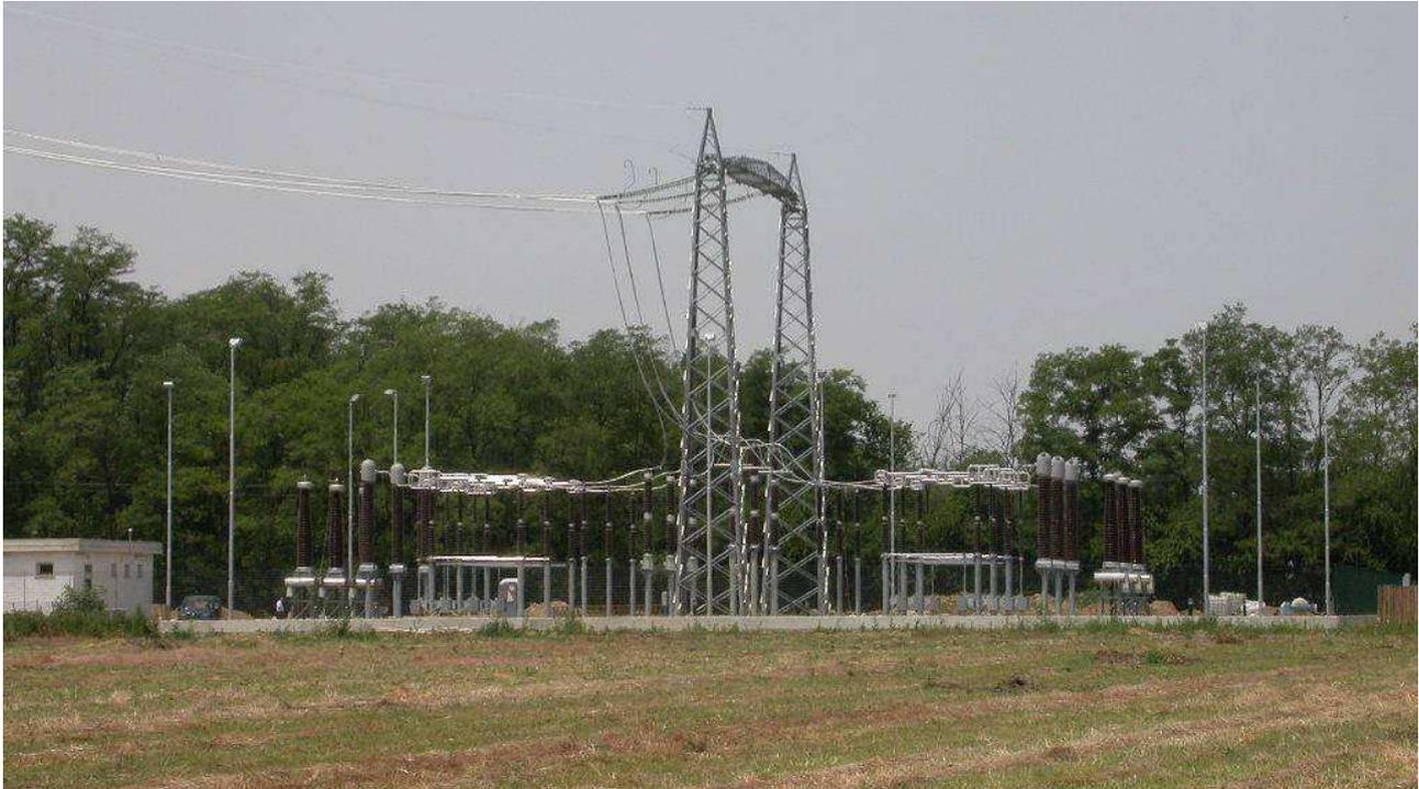
*Figura 2-9- Stazione di transizione aereo/cavo priva di reattanze per linea 380 kV in semplice terna aerea/doppia terna in cavo*
