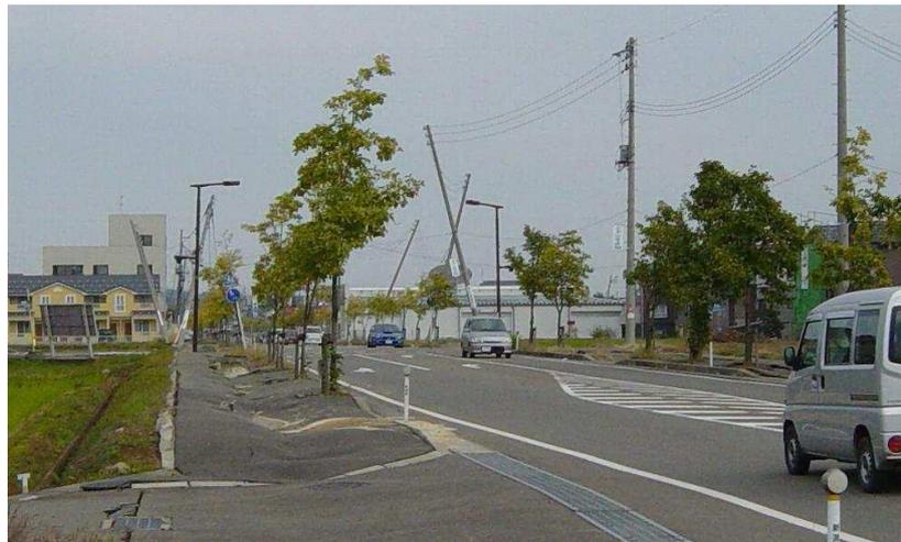
*Figura 2-12– effetti derivanti da liquefazione (evento sismico a Chuetsu in Giappone)*
