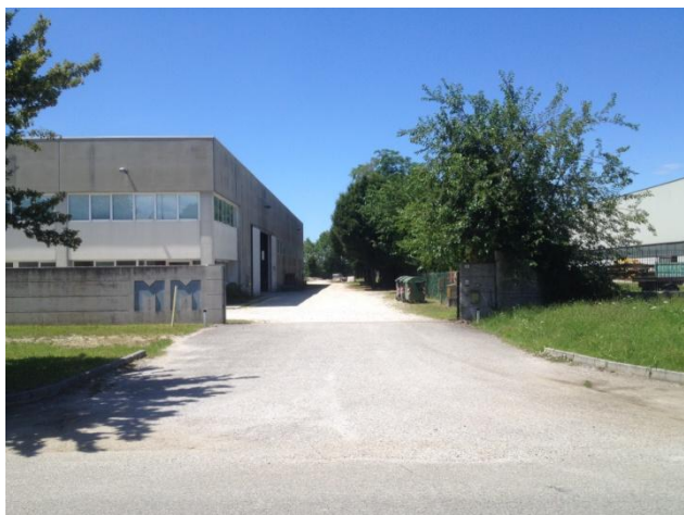
Figura 1 – Ingresso capannone, zona ufficio
