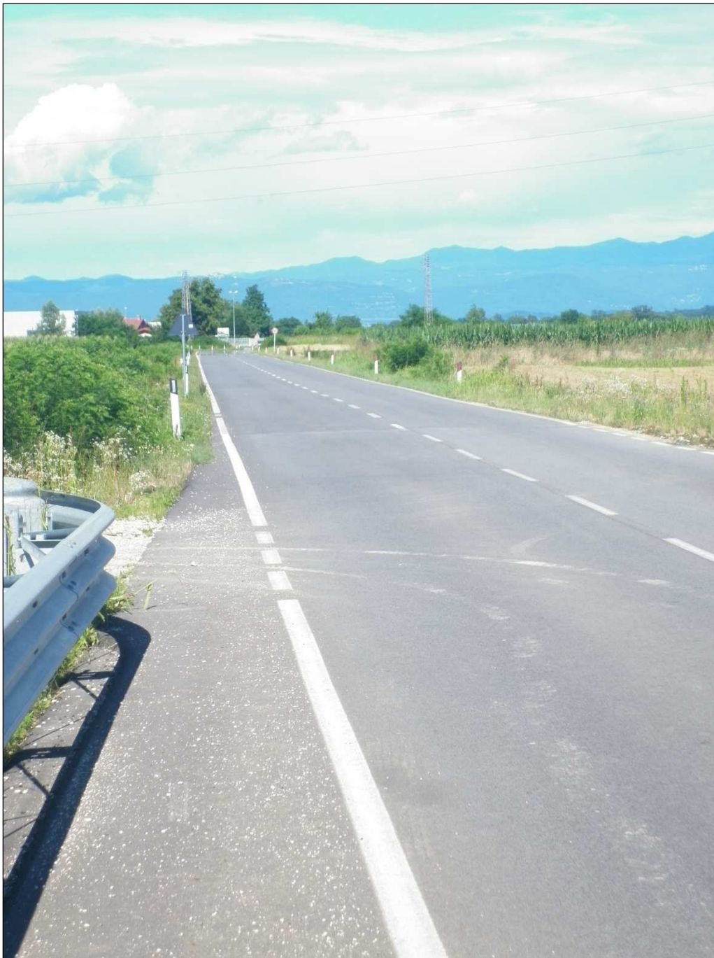
Figura 7.4: esempio di attraversamento di infrastruttura viaria, la Strada Provinciale n°50.
