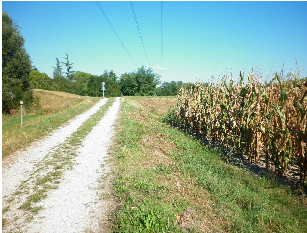
Figura 21 Parte interna all'argine in sinistra idrografica del fiume Isonzo.
