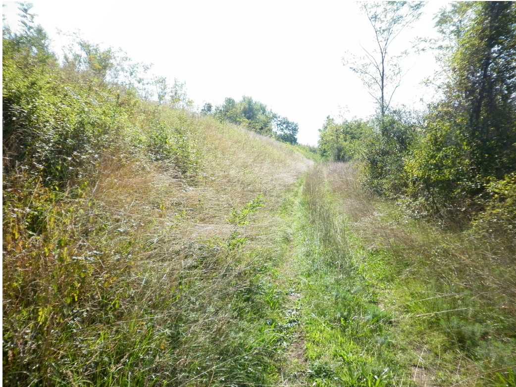
Figura 20 Parte interna all'argine in destra idrografica del fiume Isonzo.
