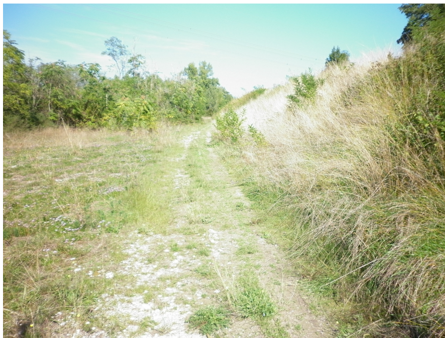
Figura 18 Area esterna all'argine in destra idrografica del fiume Isonzo da cui partirà la TOC.
