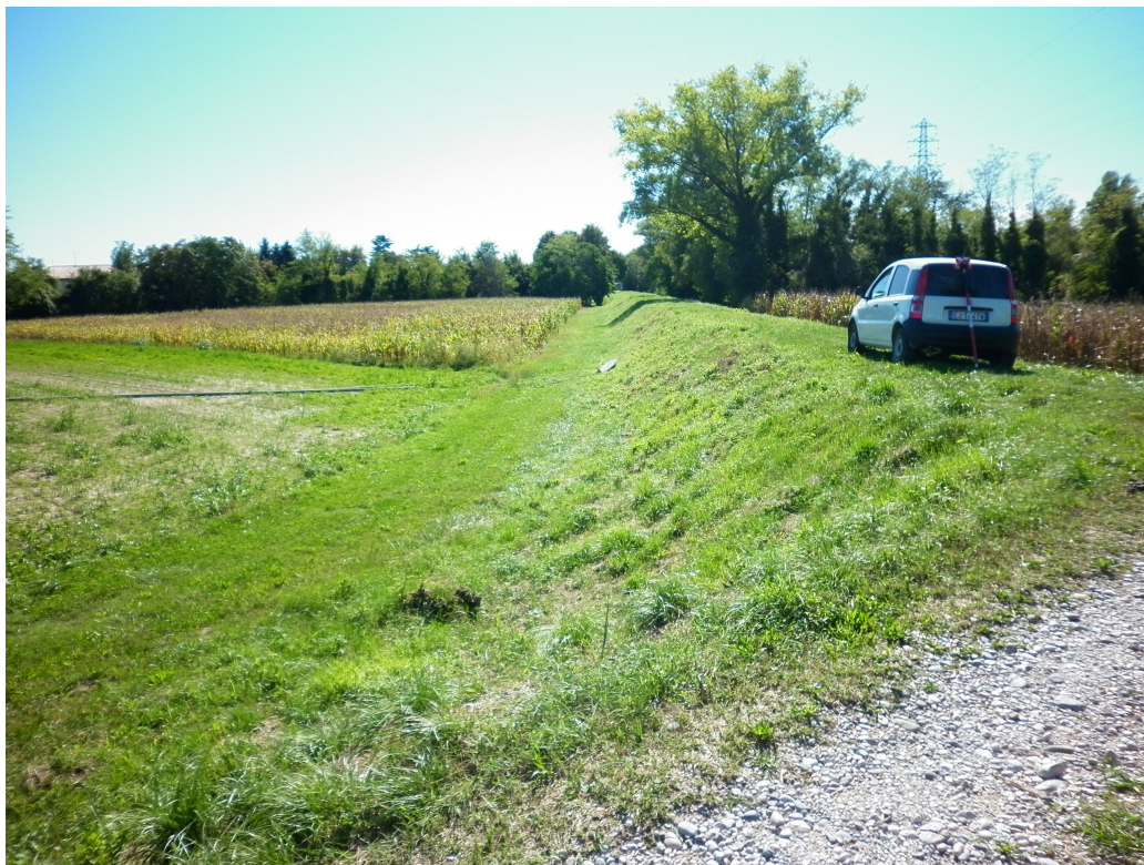
Figura 22 Argine in sinistra idrografica del fiume Isonzo.
