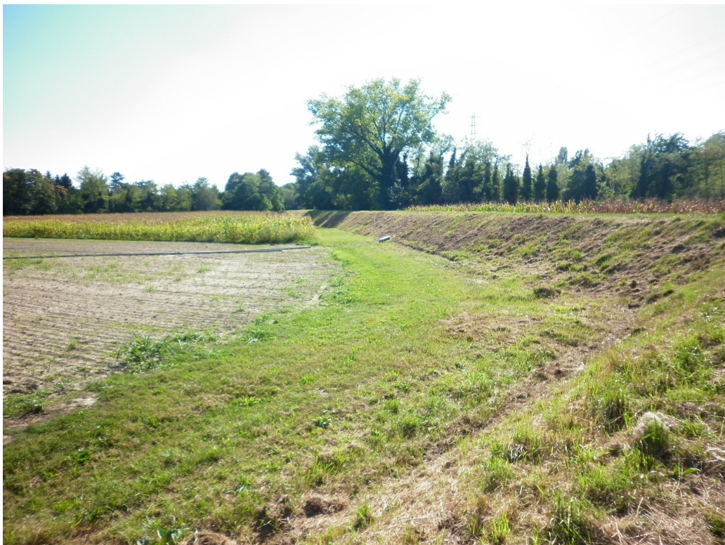
Figura 23 Area esterna all'argine in sinistra idrografica del fiume Isonzo in cui terminerà la TOC.
