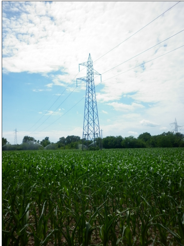
Figura 7.1: L'attuale picchetto n. 11, che verrà sostituito con uno adatto alla transizione da linea aerea a cavo interrato.
