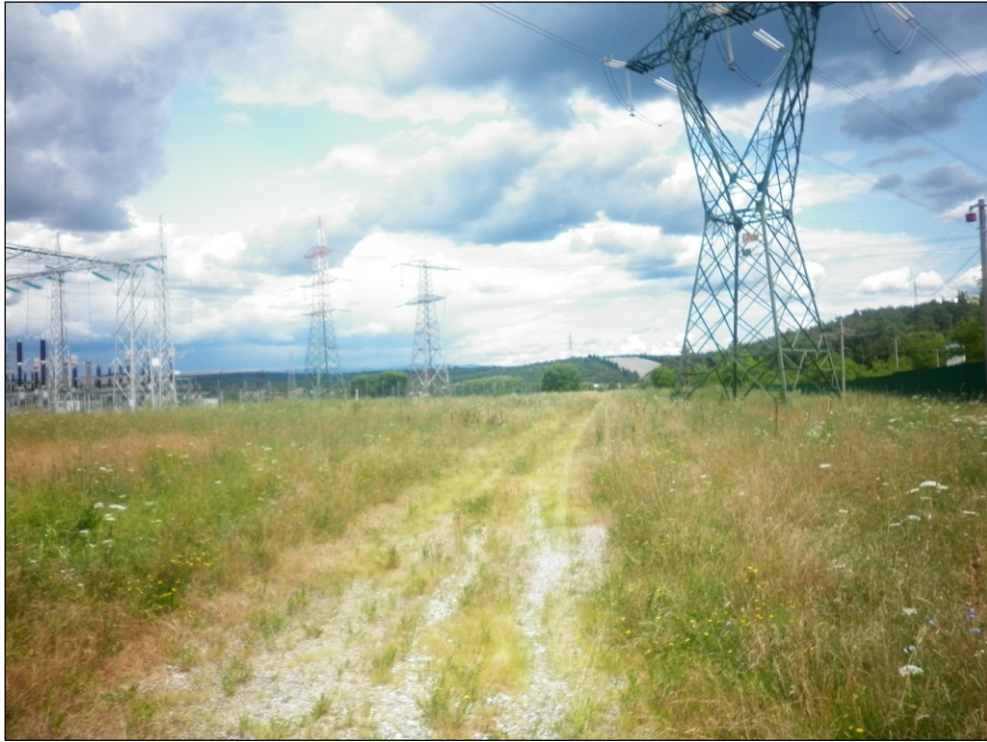
Figura 7.10: la Stazione Elettrica di Redipuglia.
