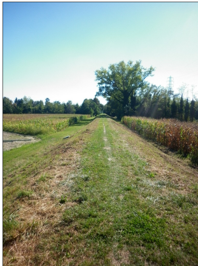
Figura 7.3: L'argine in sinistra orografica del fiume Isonzo.
