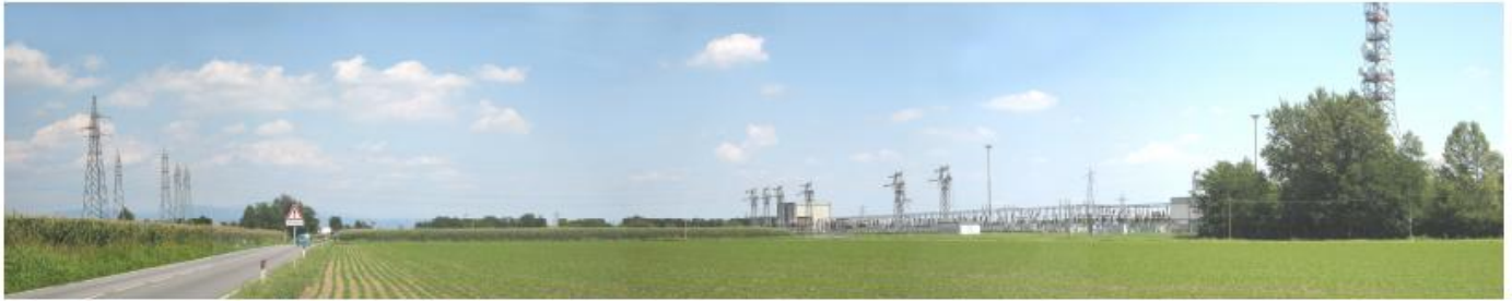
Foto 3-1: panoramica da Ovest, dello stato attuale della stazione elettrica di Udine Ovest
