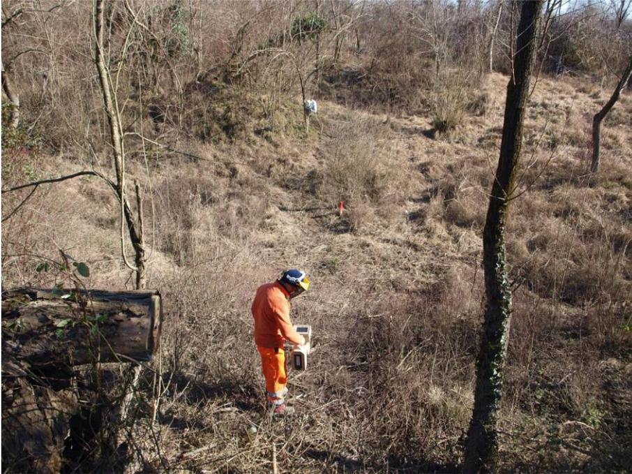
**Foto 5: Sequenza fotografica (punti 2÷8) lungo il corridoio di taglio effettuato per la realizzazione del cavo interrato verso il punto di ripartenza TOC – presenza di operatore con sonda di rilevamento posizione perforazione tubo interrato**
