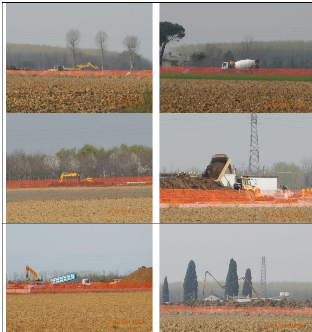
Figura 3 – S.E. di Udine Sud: campagna n° 3 del Marzo 2014 - Immagini fotografiche delle lavorazioni in corso presso il cantiere
