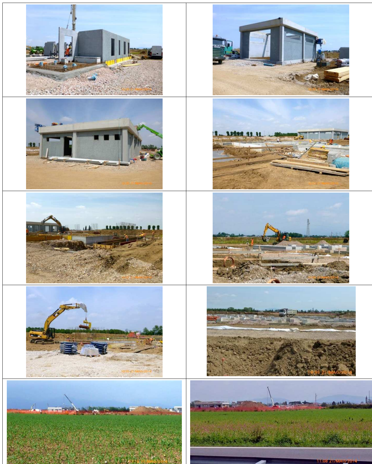
Figura 2 – S.E. di Udine Sud: campagna n° 4 del Maggio 2014 - Immagini fotografiche delle lavorazioni in corso presso il cantiere
