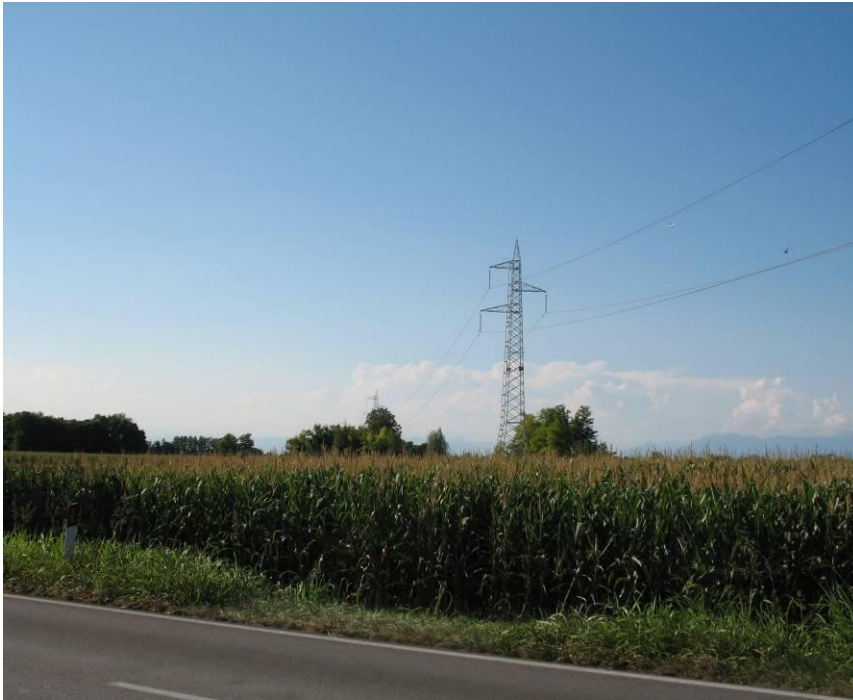
Foto 6.1: (traliccio 64) Stato attuale (loc. Ialmicco UD)
