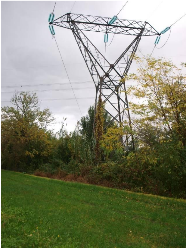
Vista dall'esterno (lato vigneto)
