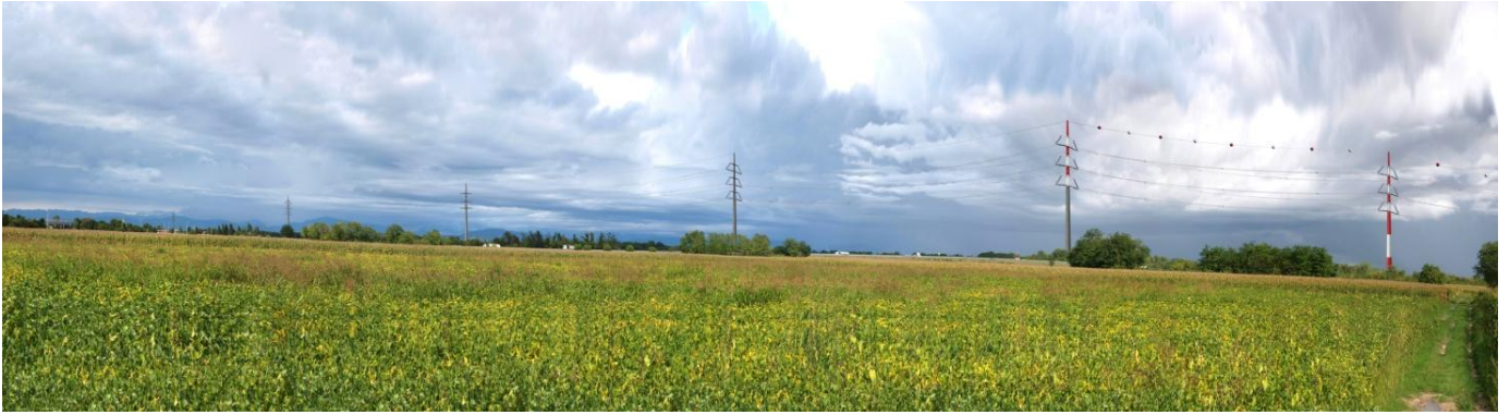
Foto 3: Fotosimulazione attraversamento T. Torre (visibili le palle colorate di segnalazione per aerea di interesse aeroporto di Ronchi)
