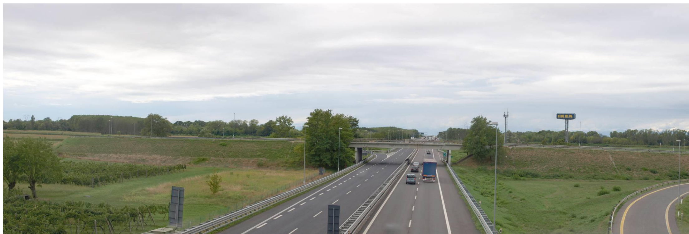
Foto 4: Visuale 2 - Stato attuale
