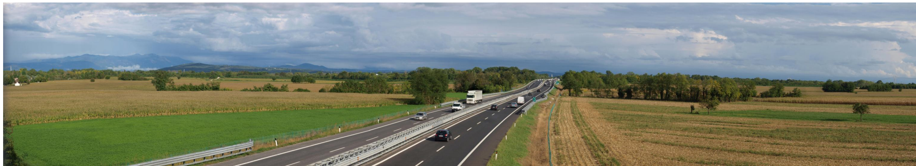
Foto 7: Visuale 3 - Stato attuale
