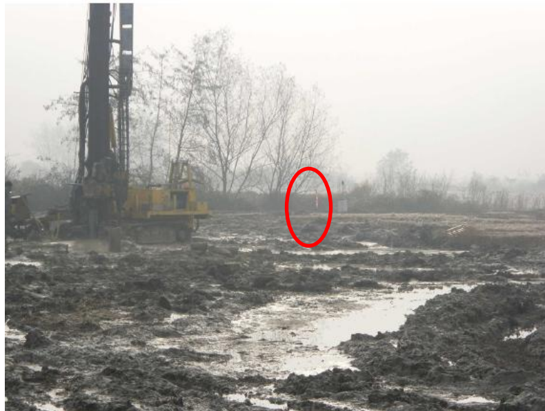
Figura 5-1 - Cantiere per la realizzazione delle fondazioni. Cerchiato in rosso il fonometro.
