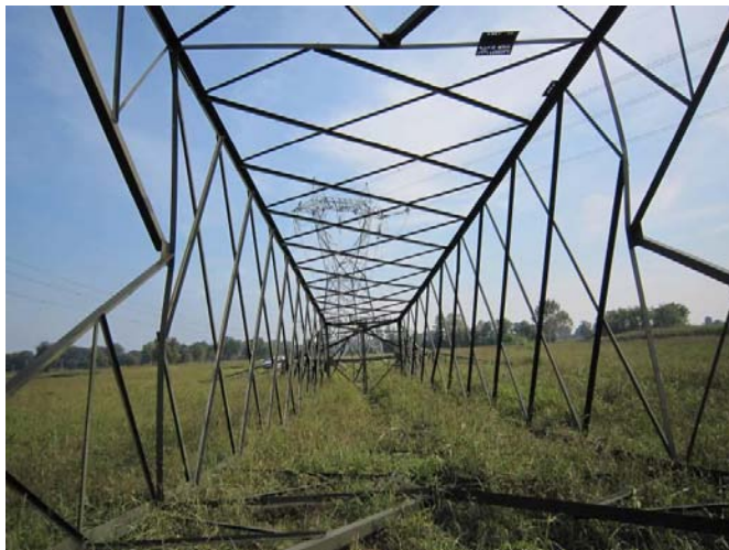
Demolizione di un sostegno a traliccio
