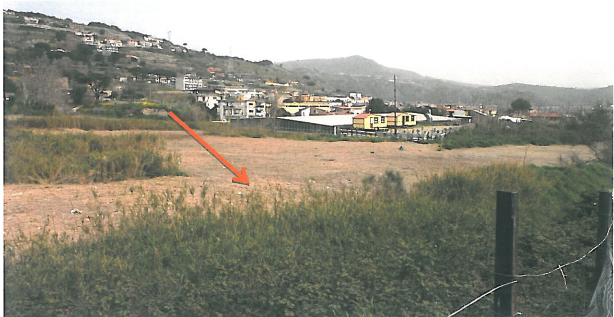
Fig. 31 – 32 - Ubicazione pozzo P3 in Zona D1 del P.R.G. - Zona industriale, artigianale e commerciale esistente
