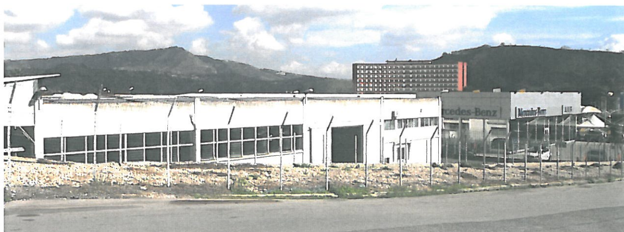
Fig. 23 - Prospetto dell'attuale capannone verso via Antiniana
