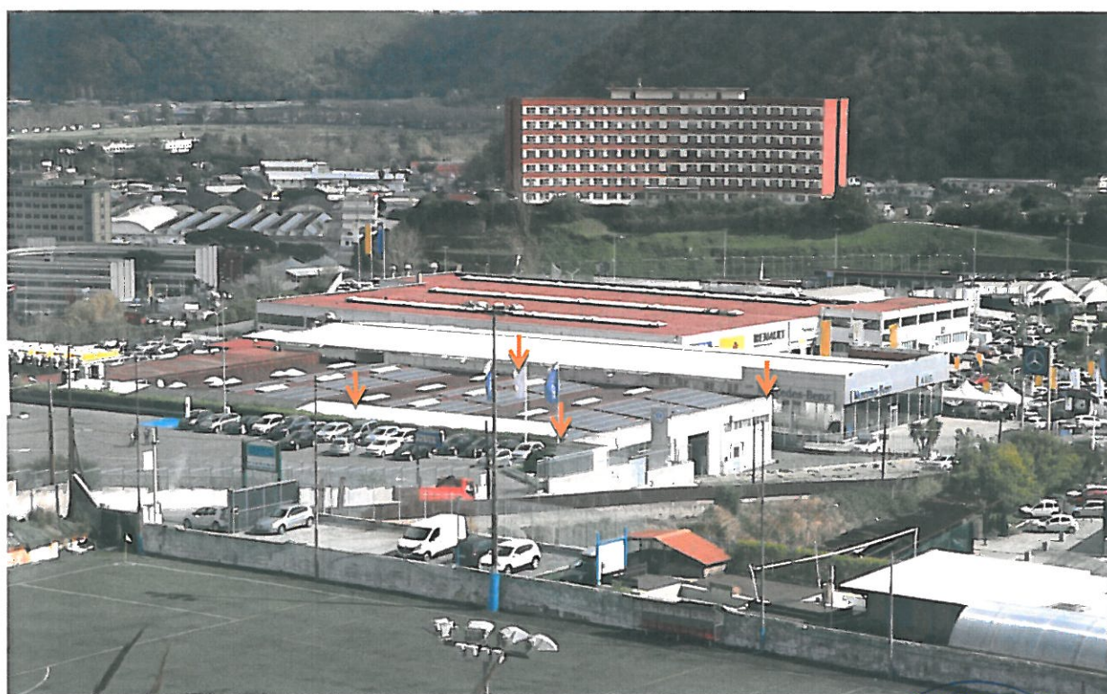
Fig. 8-9 - Le frecce indicano i limiti del capannone in cui realizzare l'impianto di produzione
