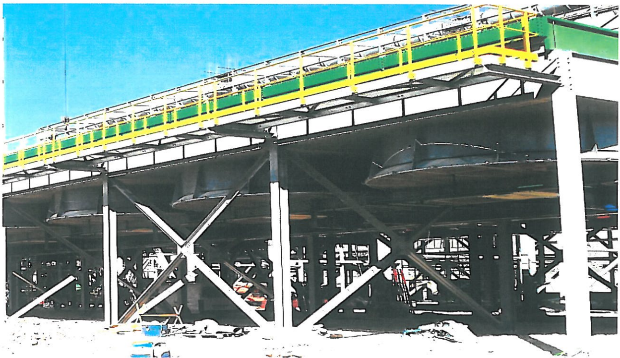
Fig. 12 - Condensatore con aerotermi
