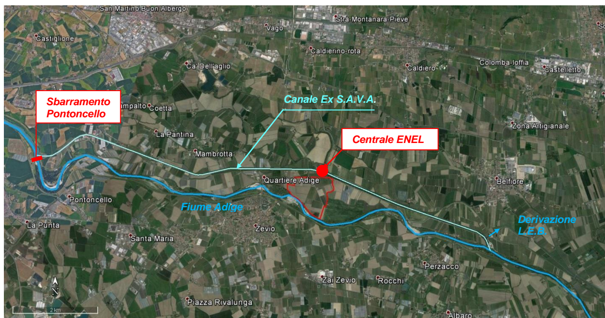
Figura 2.4 – Inquadramento sbarramento di Pontoncello – Canale Ex S.A.V.A – fiume Adige.
