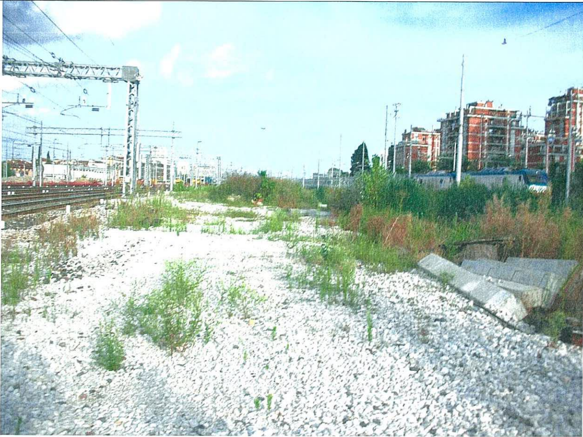
Fig. 7 – Vista dell'area destinata al cantiere di armamento e tecnologie
