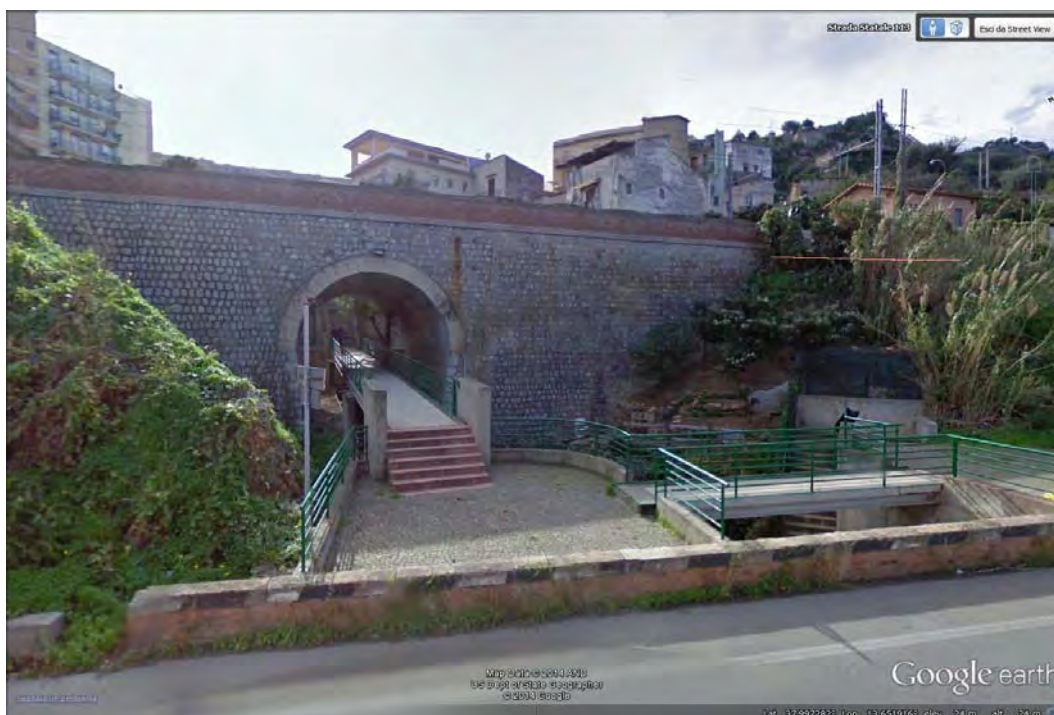
Trabia (PA): 37.997214°, 13.651882° - singolare arredo urbano
