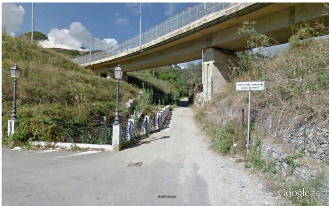
Messina: 38.226329°, 15.546516° - torrente Annunziata: cartello che esplicita l'inizio del torrente e quindi, di fatto, la sussistenza della strada-alveo
