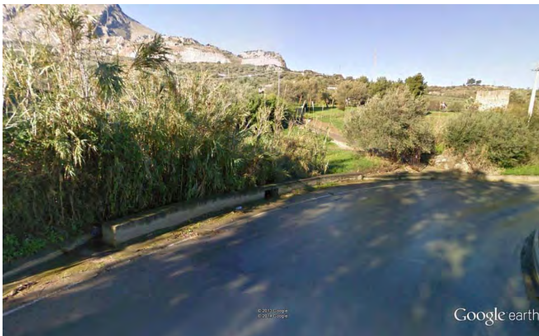
Termini Imerese (PA): 37.947419°, 13.773591° - sbocco di un torrente del 2° ordine su SP21
