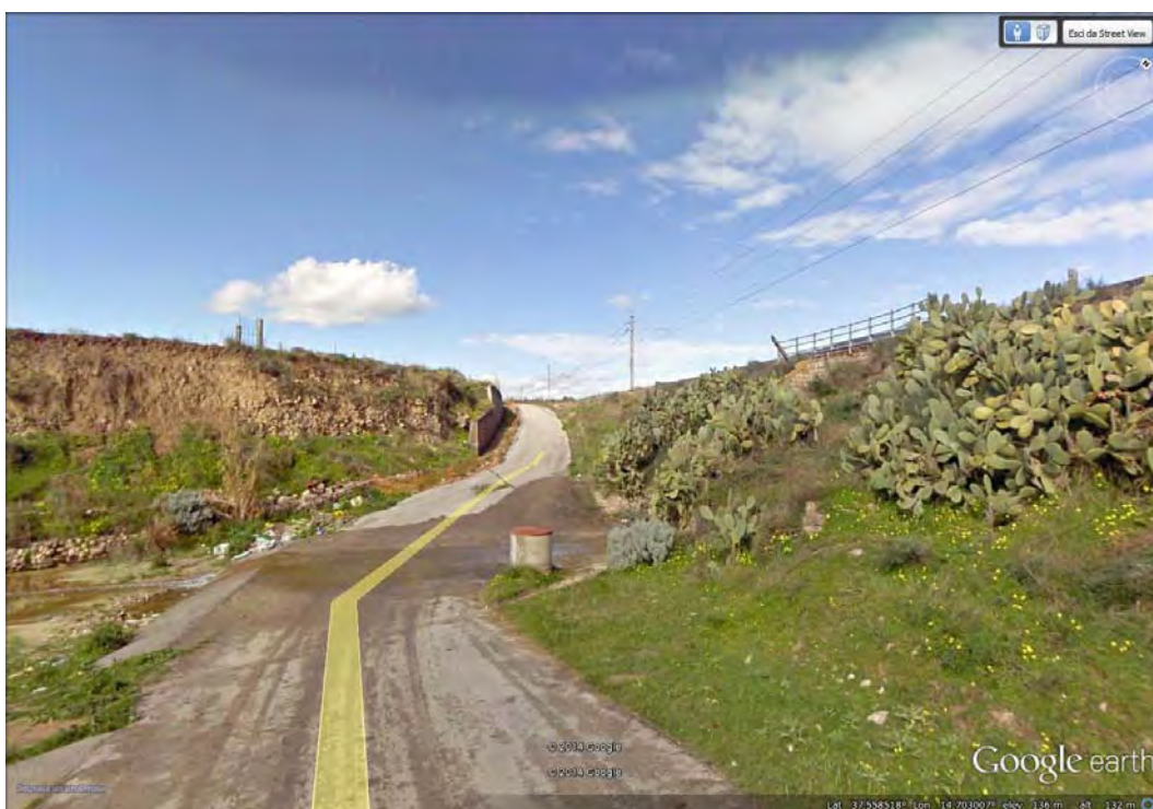
Catenanuova (EN): 37.558518°, 14.703007° - attraversamento a guado lungo una strada comunale sul Vallone della Rosa, affluente del Fiume Dittaino
