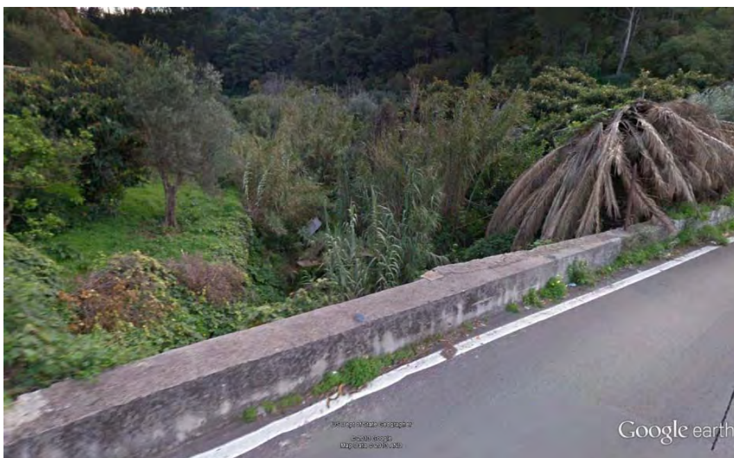
Altofonte (PA): 38.048091°, 13.311363° - attraversamento sulla SP5
