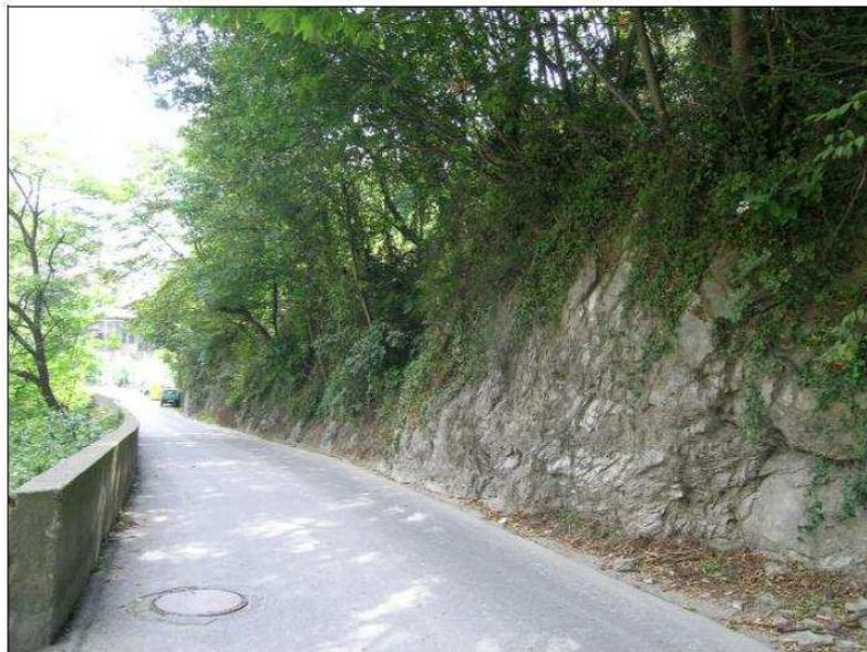
Foto 2 - Scarpata tratto sezz. 3-7: vista dal settore centrale verso valle; il piede roccioso in argilloscisti da un' altezza di 4-5 m diminuisce velocemente di altezza fino a 2m
