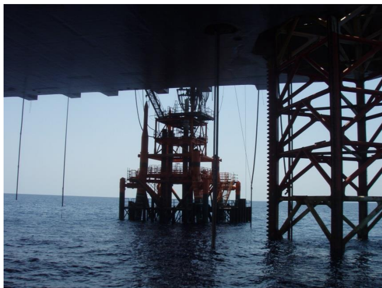
Fig. 2.5 - Jackup in primo piano e jacket della piattaforma Bonaccia NW sullo sfondo.
