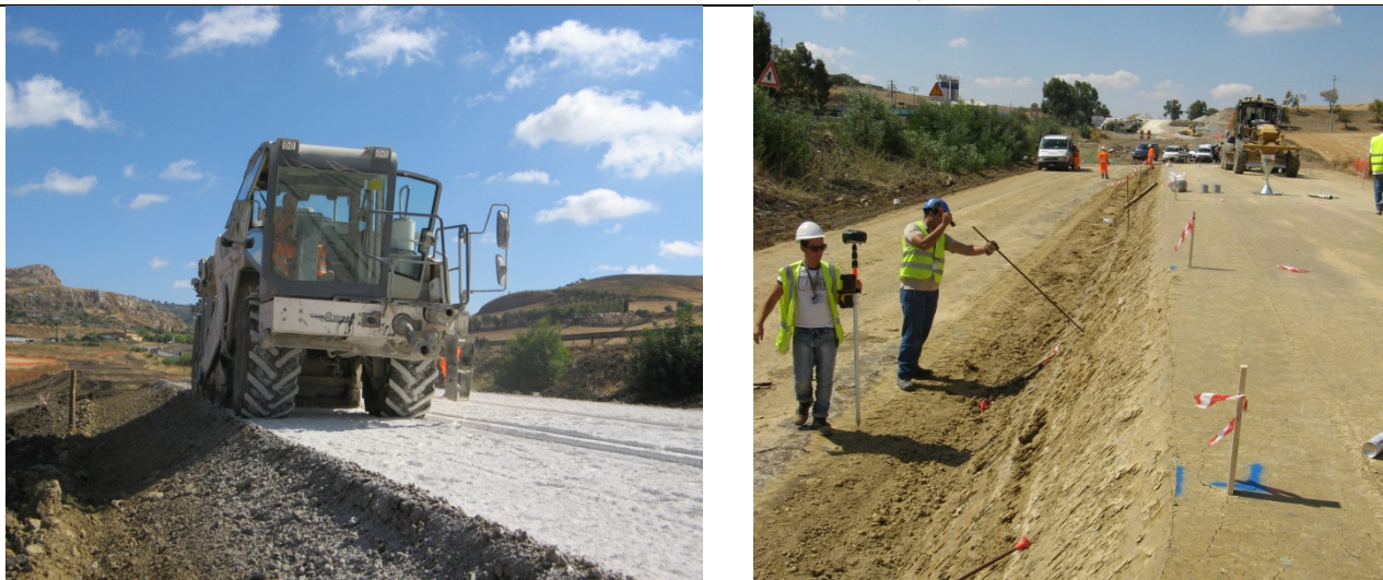
Figura 16 - Rilevato sperimentale in fase di costruzione e dopo sagomatura delle scarpate
