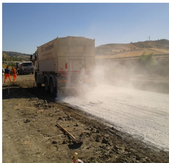
Figura 12 - Spandimento della calce e controlli
