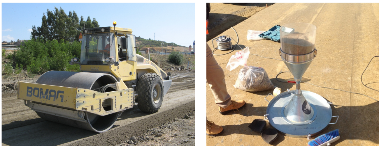
Figura 14 – Attrezzature impiegate per la compattazione degli strati posti in opera ed i controlli di densità
