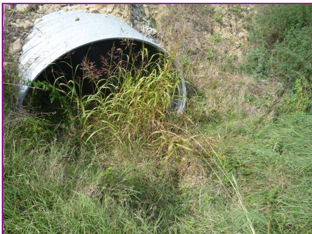
In prossimità del sottopasso Fau\_08 invece sono state trovate delle impronte di cervidi, probabilmente caprioli, anche se data la dimensione dell'armco utilizzato per il sottopasso, lo stesso non potrebbe essere sfruttato da animali di taglia medio-grande.
