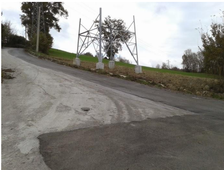
Figura – L'immagine mostra come l'area di occupazione in fase di esercizio, sia solo quella propria del traliccio stesso essendo l'area circostante totalmente ripristinata allo stato precedente.
