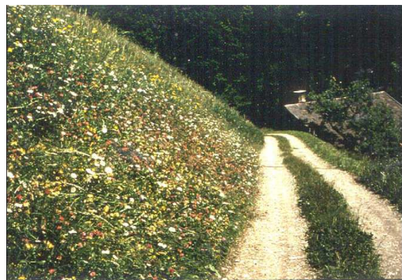
Esempio di scarpatata dopo idrosemina
