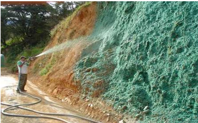
Tecnica di idrosemina
