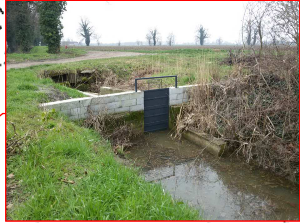
Manufatto di sbarramento (la sua chiusura provoca l'invaso d'acqua e ne impedisce lo smaltimento)
