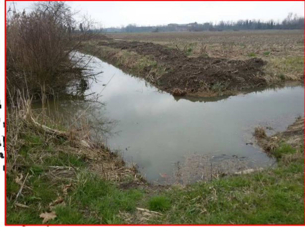
Tratto iniziale del Cavo Tombone (deflusso impedito dai manufatti a valle)
