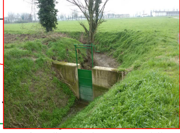
Manufatto di regolazione a monte della località Caselle
