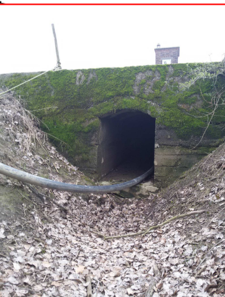
Manufatto di attraversamento dell'argine maestro, lato nord
