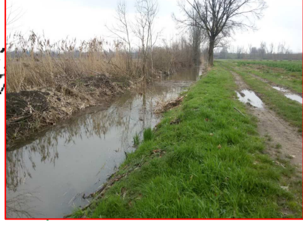
Cavo Tombone nel tratto iniziale (ristagno idrico e deflusso impedito da manufatti esistenti a valle)
