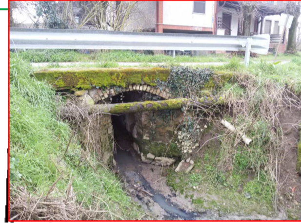
Ingresso della tombinatura presso Località Caselle (tratto in evidente contropendenza)
