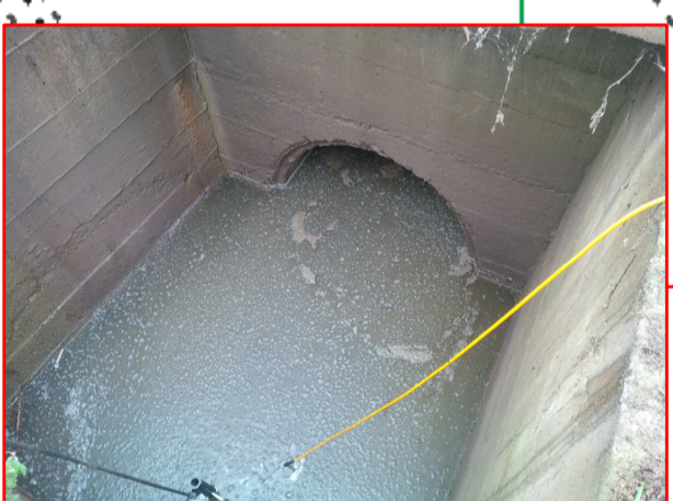
Pozzetto di ispezione della tombinatura presso località Caselle (tubazione in uscita)
