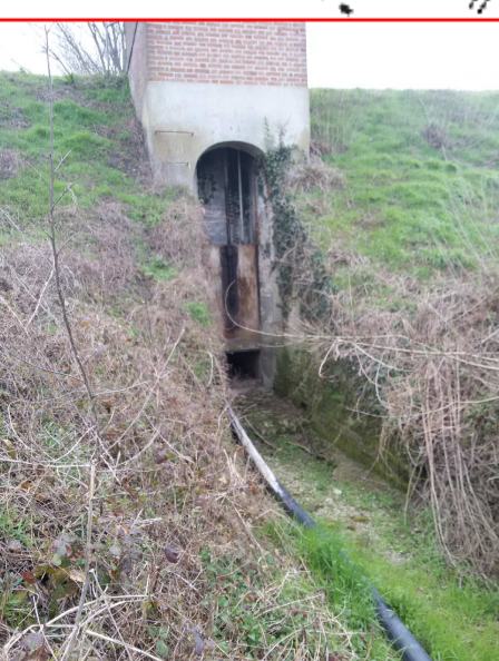
Manufatto di attraversamento dell'argine maestro, lato sud
