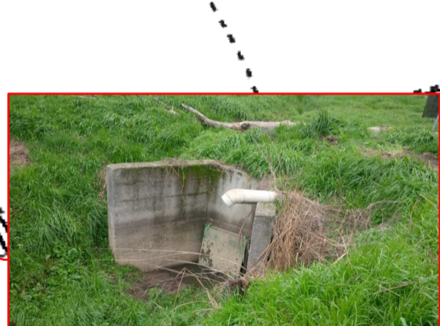
Uscita del tratto tombinato presso località Caselle
