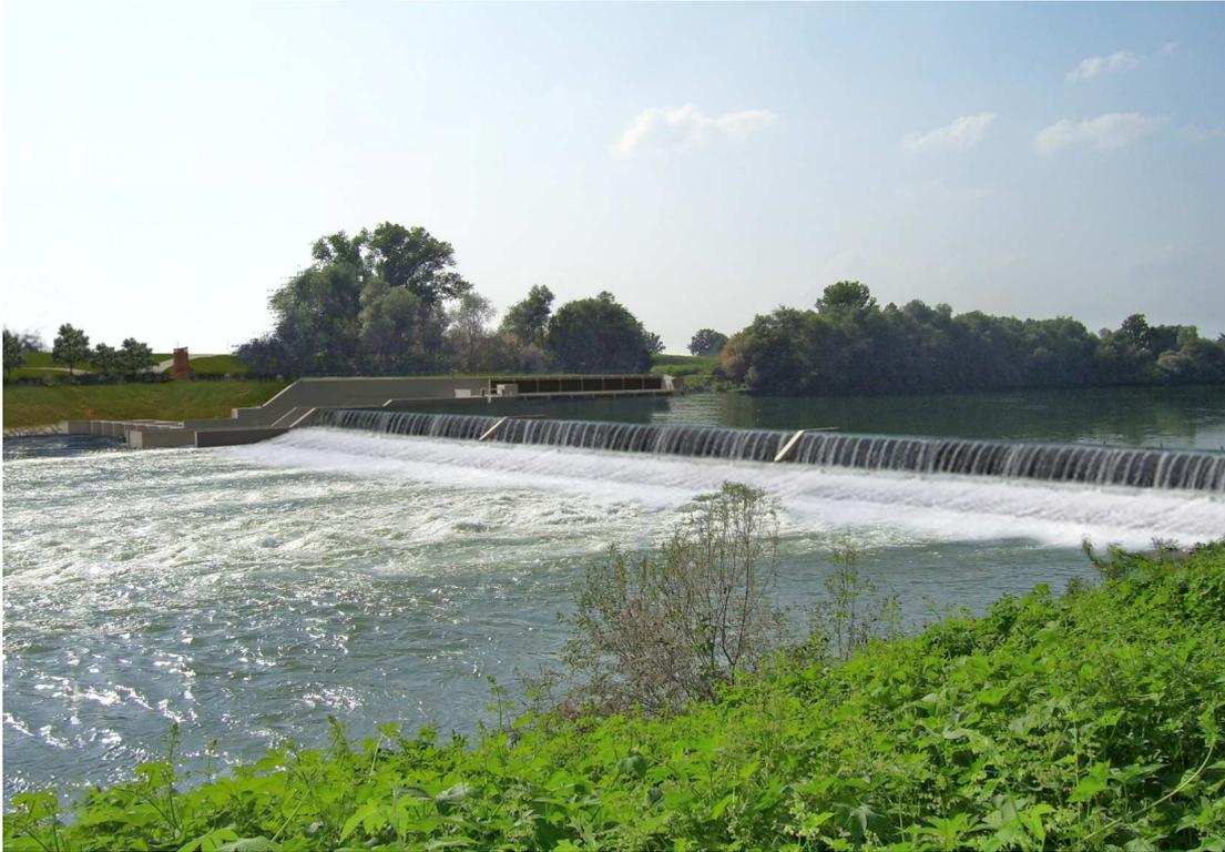
*Fig. 52: Foto simulazione dello sbarramento di Budriesse con sfioro di mascheramento di 5 cm*
