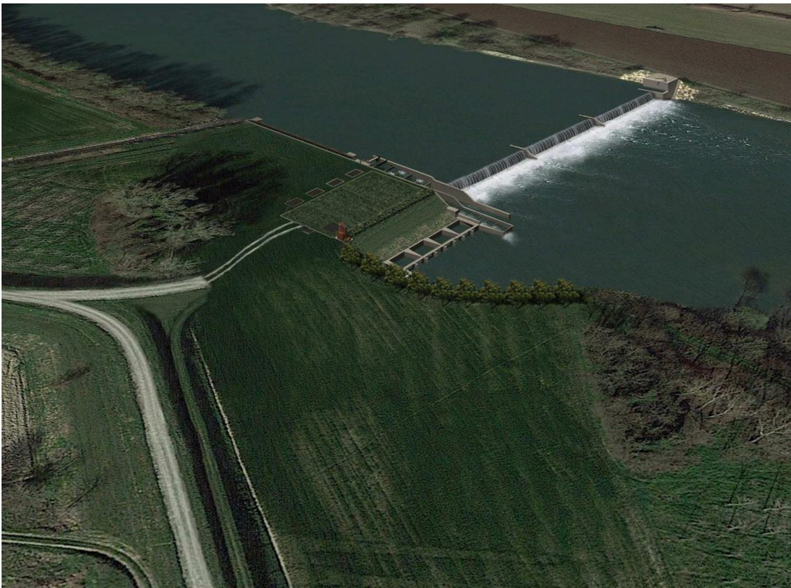
*Fig. 55: Foto simulazione dello sbarramento di Budriesse con sfioro di mascheramento di 5 cm*
