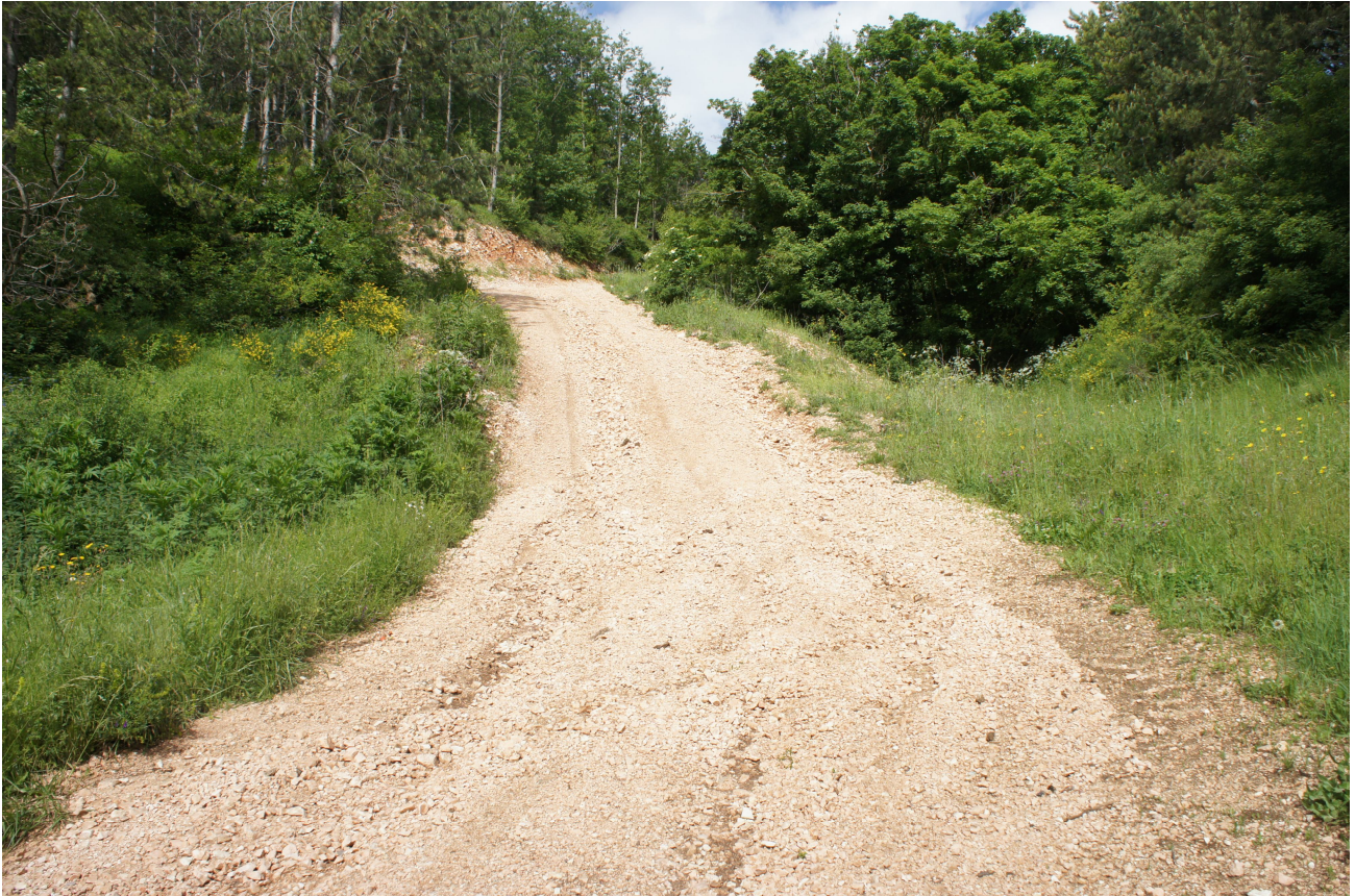
Figura 6 – Immagine della strada di cantiere che attraversa un'area a bosco misto.
