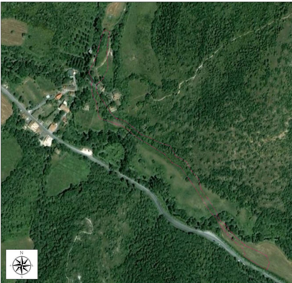
Figura 3 - Ortofoto dello stato di fatto Ante Operam della strada 22.
