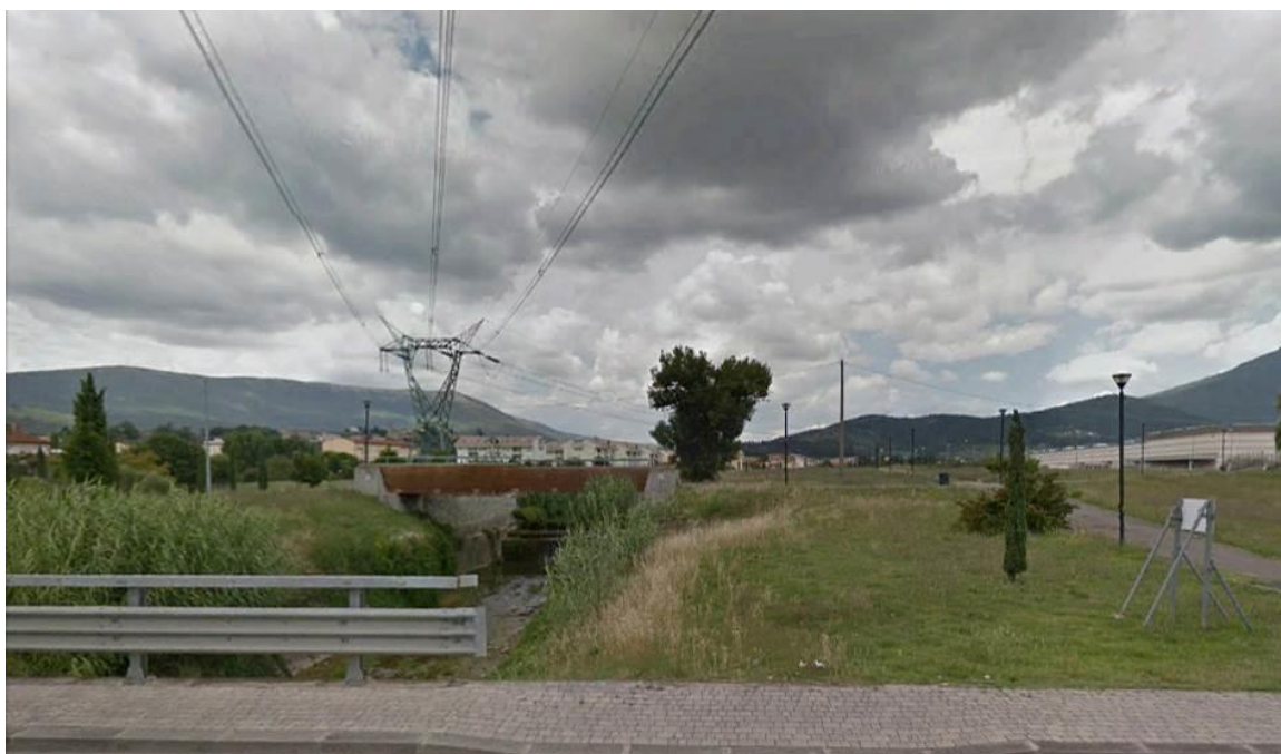
Foto I - Vista da via Prato verso nord, lungo il torrente Garille. L'elettrodotto a 380 kV Bargi-Calenzano visibile sarà demolito e il nuovo sostegno n. 229 sarà realizzato in sponda sinistra.
