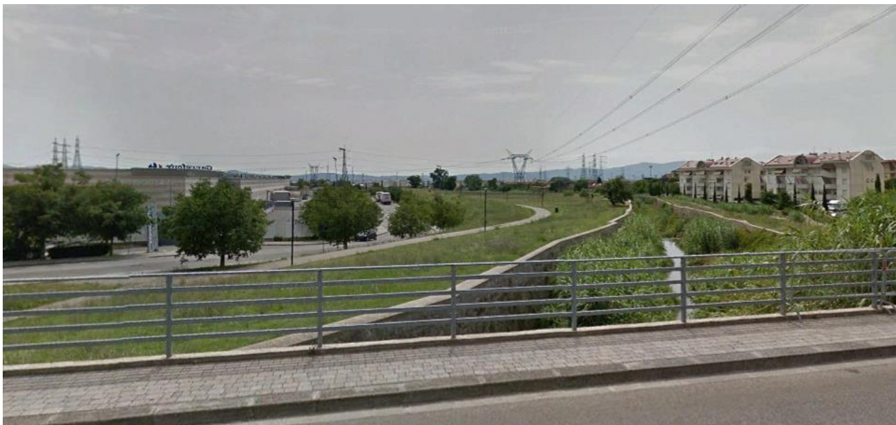
Foto i - Vista da via del Garille verso sud lungo il Torrente omonimo, costretto tra argini in area industriale-commerciale. La linea esistente a 380 kV Bargi - Calenzano sarà demolita
