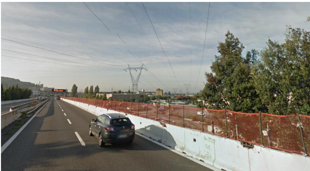
FOTO 4: Vista in direzione Firenze. Sopra l'osservatore i conduttori della linea esistente a 132 kV "Barberino – Calenzano" di prevista demolizione. Più avanti la linea a 220 kV "Casellina – S. Benedetto del Querceto" che in questo tratto sarà sostituita dalla linea in progetto. Nell'attraversamento dell'infrastruttura la linea in progetto mantiene lo stesso andamento dell'esistente, mentre curva verso destra successivamente risultando coperta dalla vegetazione in questa ripresa fotografica. Si noti come al di sotto delle due linee sia presente un ambito fortemente degradato.
