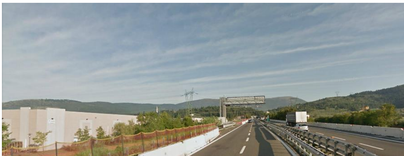
FOTO 10: Vista in lontananza verso nord-ovest del tratto di attraversamento dell'autostrada da parte della linea in progetto. Essa in questo tratto mantiene pressoché lo stesso andamento della linea esistente a 220 kV "Casellina – S. Benedetto del Querceto" che sarà demolita.
