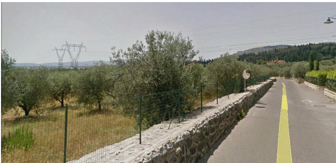
Foto b - Vista da via delle vigne verso ovest. Si osserva l'attraversamento stradale da parte delle due linee esistenti di prevista demolizione. Sullo sfondo a destra il rilievo morfologico di Villa San Donato
