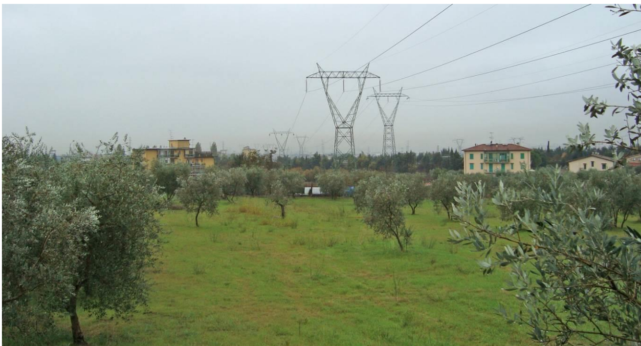
Foto c - Vista da via delle vigne verso sud. Sulla sinistra la linea a 220 kV Casellina - S. Benedetto del Querceto; a destra la linea 132 kV Barberino - Calenzano, entrambe di prevista demolizione. In questo tratto la linea in progetto segue all'incirca l'andamento della linea a 220 kV. Il sostegno n. 220 sarà realizzato all'interno dell'uliveto rado.
