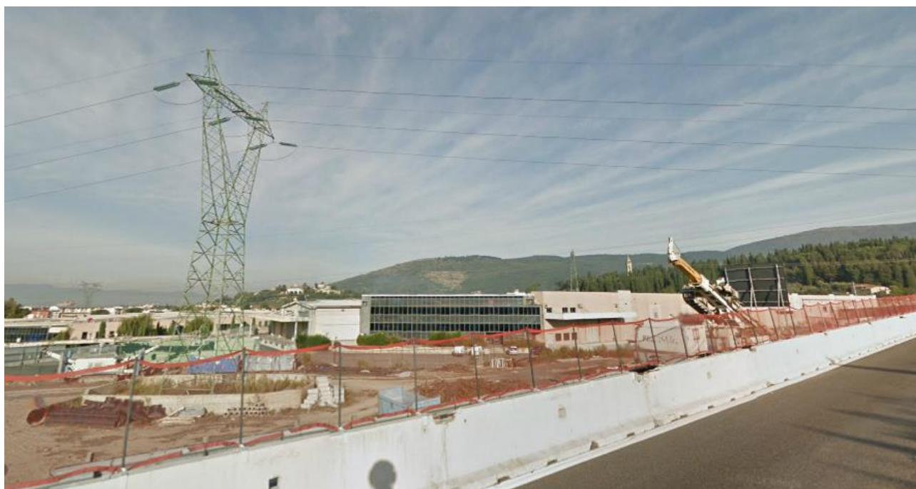
FOTO 6: Vista verso ovest. In primo piano il sostegno della linea a 220 kV "Casellina – S. Benedetto del Querceto" da demolire; a sinistra di esso sarà realizzato il nuovo sostegno n. 222 della linea in progetto. Si noti come al di sotto della linea sia presente un ambito industriale fortemente degradato. Le visuali dall'autostrada verso il rilievo morfologico di pregio paesaggistico risultano fortemente disturbate.
