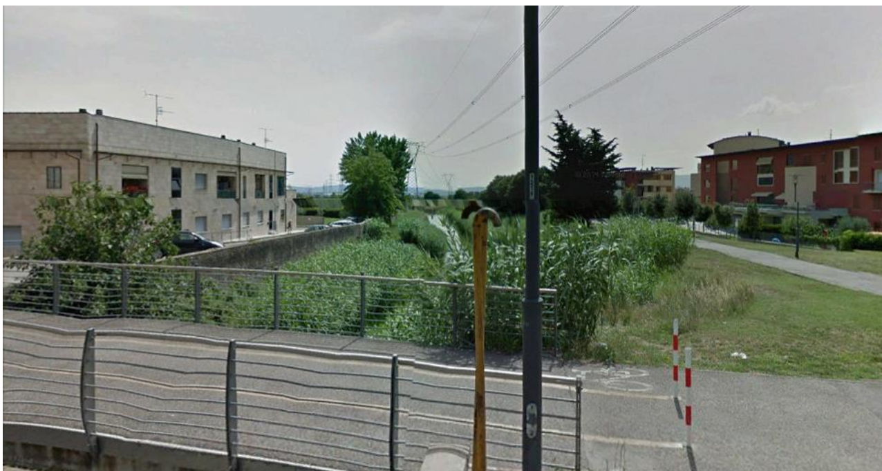
Foto g - Vista da via Giusti verso sud, lungo il T. Chiosina-Garille. In questo tratto la nuova linea ricalca fedelmente l'andamento della linea a 380 kV Bargi - Calenzano che sarà demolita.
