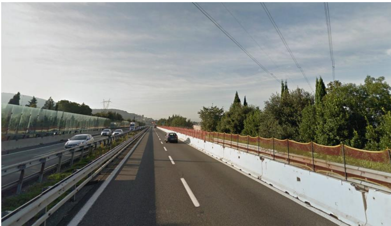
FOTO 2: Vista in direzione Firenze. Sopra l'osservatore i conduttori della linea a 380 kV Bargi stazione – Calenzano esistente di prevista demolizione. La visuale è qui disturbata a nord dalle barriere acustiche e a sud dalla presenza di vegetazione.
