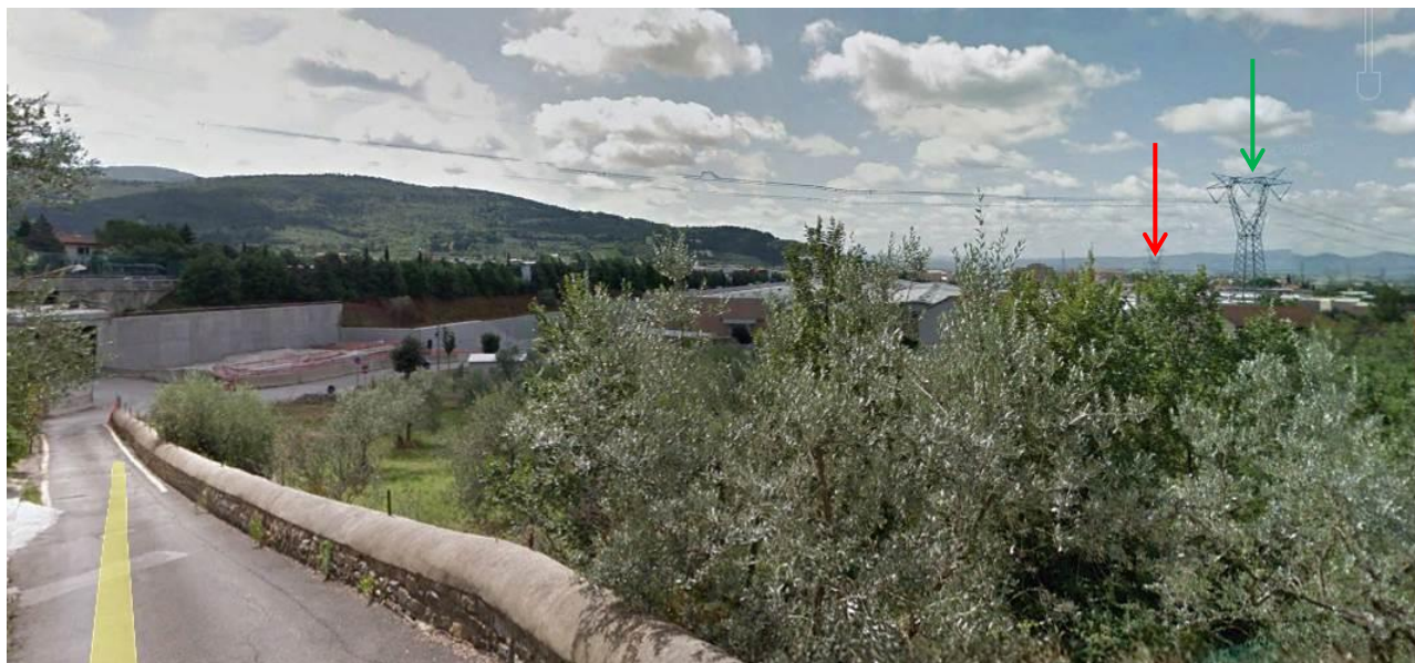
FOTO 14: Vista dal fondo di via S. Donato, in prossimità del sottopasso dell'autostrada. La freccia verde indica il sostegno della linea più vicina che sarà demolita, la freccia rossa indica il sostegno della linea più lontana che sarà demolita e in prossimità della quale sarà realizzata la linea in progetto.
