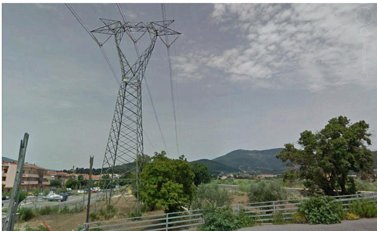
Foto h - Vista da via del Garille verso nord lungo il Torrente omonimo, sullo sfondo il Massiccio del Monte Morello. La linea esistente a 380 kV Bargi - Calenzano sarà demolita
