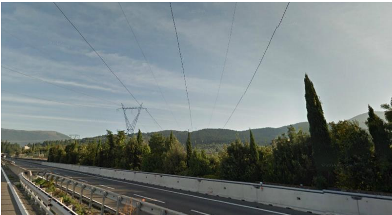
FOTO 7: Vista verso nord. Sopra l'osservatore corrono i conduttori della linea 220 kV "Casellina – S. Benedetto del Querceto" da demolire; la linea in progetto avrà pressoché lo stesso andamento della linea esistente in questo tratto. A sinistra si osservano le altre due linee oggetto di demolizione. Si noti come da questo lato dell'autostrada la visuale di pregio sui rilievi sia parzialmente limitata dalla presenza della folla vegetazione.
