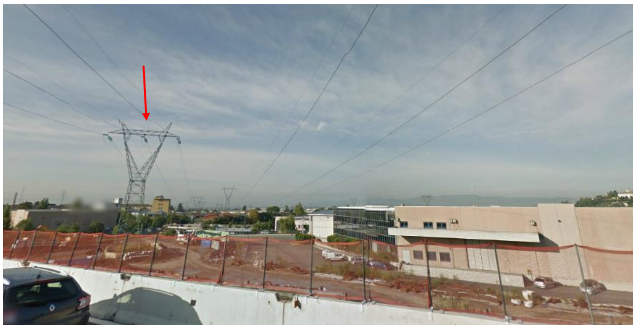
FOTO 5: Vista verso sud-ovest del varco sotto le due linee a 132 kV e 220 kV di prevista demolizione. Il sostegno 222 in progetto, di tipologia tubolare monostelo, sarà realizzato poco a sinistra dell'esistente della linea 220 kV "Casellina – S. Benedetto del Querceto" (freccia rossa), mentre il successivo si posizionerà sull'asse della linea 132 kV "Barberino - Calenzano", per poi allinearsi alla linea 380 kV "Bargi stazione – Calenzano" visibile in lontananza sulla destra. Tutte e tre le linee visibili nella foto saranno demolite a fronte della realizzazione della linea in progetto. Si noti come al di sotto delle due linee sia presente un ambito fortemente degradato.
