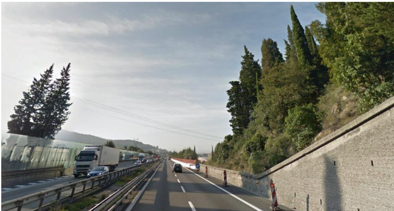
FOTO 1: Vista in uscita dalla galleria autostradale, direzione Firenze, della linea a 380 kV esistente "Bargi stazione – Calenzano" di prevista demolizione nell'ambito del complesso di interventi approvato con decreto di compatibilità ambientale DM 0000275 del 17/11/2014. La visuale è qui disturbata a nord dalle barriere acustiche e a sud dal rilievo morfologico.
