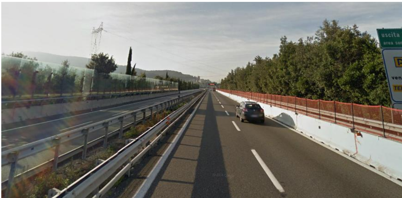
FOTO 3: Vista in direzione Firenze. Si osserva l'attraversamento della linea esistente a 132 kV "Barberino – Calenzano" di prevista demolizione. Più avanti la linea a 220 kV "Casellina – S. Benedetto del Querceto" che in questo tratto sarà sostituita dalla linea in progetto. La visuale è qui disturbata a nord dalle barriere acustiche e a sud dalla presenza di vegetazione.
