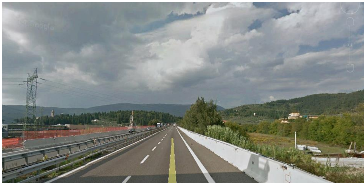
FOTO 9: Vista verso nord-ovest del tratto di attraversamento dell'autostrada da parte della linea in progetto. Essa in questo tratto mantiene pressoché lo stesso andamento della linea esistente a 220 kV "Casellina – S. Benedetto del Querceto" che sarà demolita.
