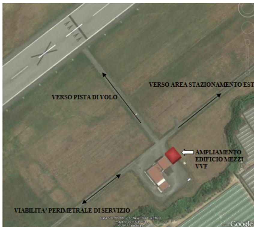
Figura 7-5 – Ampliamento Edificio Vigili del Fuoco
