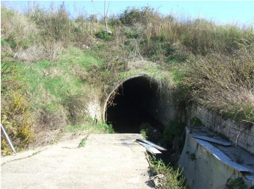
*Fig.9: Tombinatura del Torrente Volta Ladri.*
