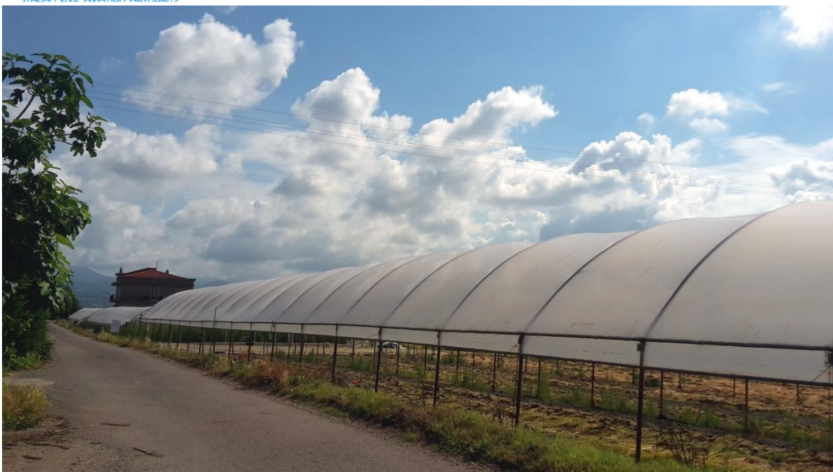
Fig. 5.2.9 - Punto di vista n.9: traversa di penetrazione di Via Lago Carezza verso l'area aeroportuale, in direzione della Testata 05 della pista di volo (Grado di intervisibilità Medio-Basso, cfr. Tav.RP.01.6 - Allegato – REL-PAE-02).
