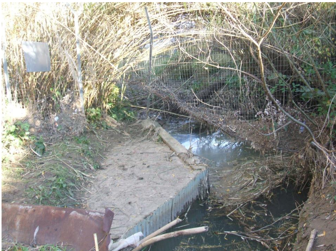
Fig. SF1.2.6: La vegetazione ostacola il deflusso nel Torrente Diavolone.
