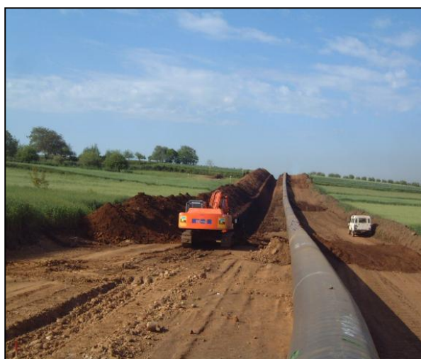
Scavo della trincea
