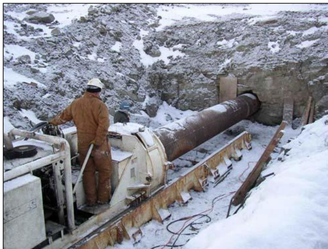
Realizzazione di attraversamento mediante presso trivella (Spingitubo)
