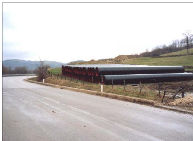
Piazzola di accatamento tubazioni
