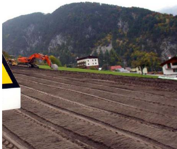
Redistribuzione dello strato di suolo fertile superficiale
